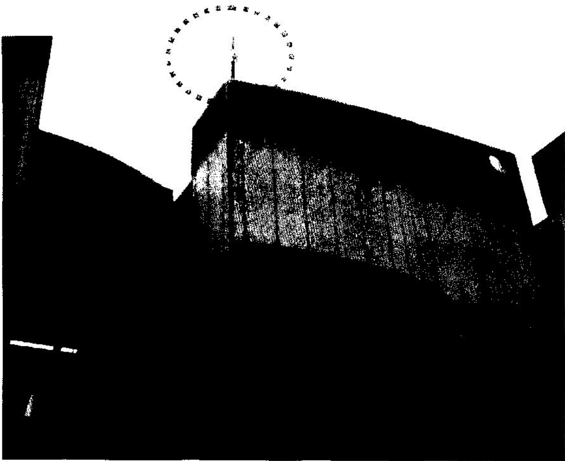
Figura 3.63 Se observa al sensor HCBC 5 (marcado con un círculo color rojo) colocado en la azotea del edificio donde se ubica la vivienda a la cual se le colocó el sistema pasivo de control solar.
