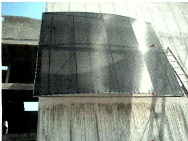
Figura 3.42 El sistema colocado en el muro visto desde abajo.
