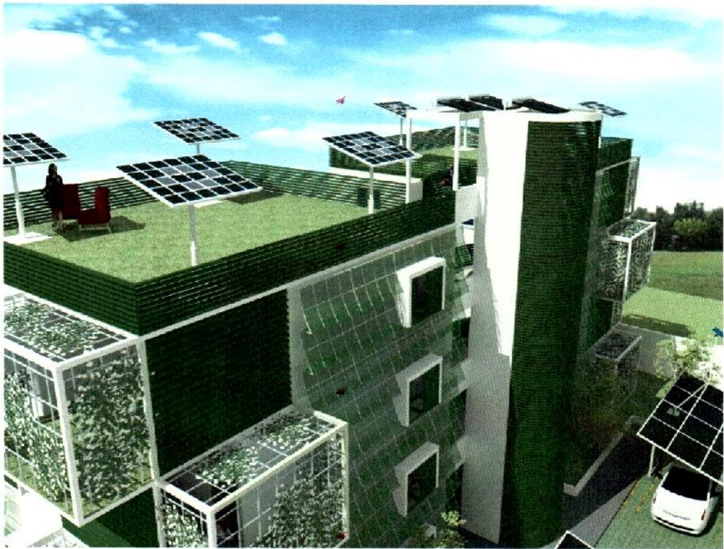
Figura 7.23 Se observa parte de la azotea recubierta de pasto y las sombrillas con paneles solares.
