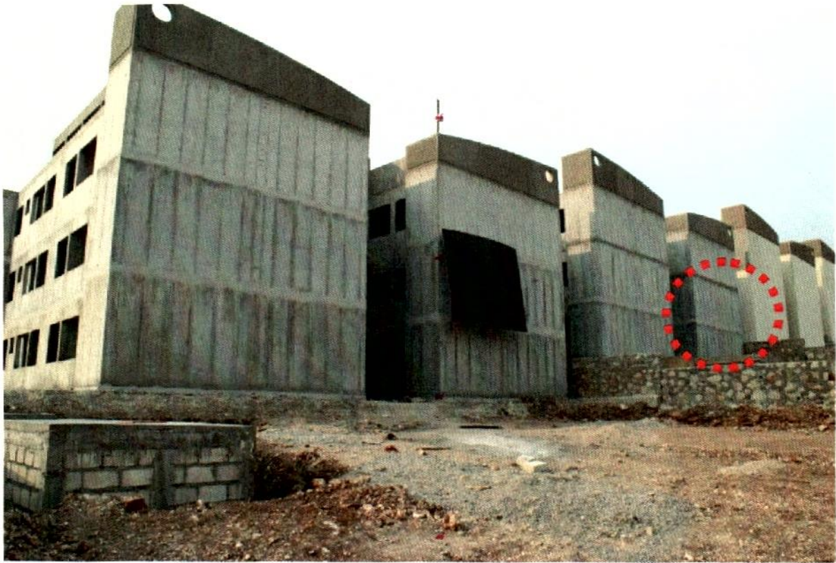
Figura 3.51 En esta fotografía se observa el sistema ya colocado en el muro de la vivienda a evaluar, así como el muro de la vivienda testigo (marcada con un círculo color rojo).
