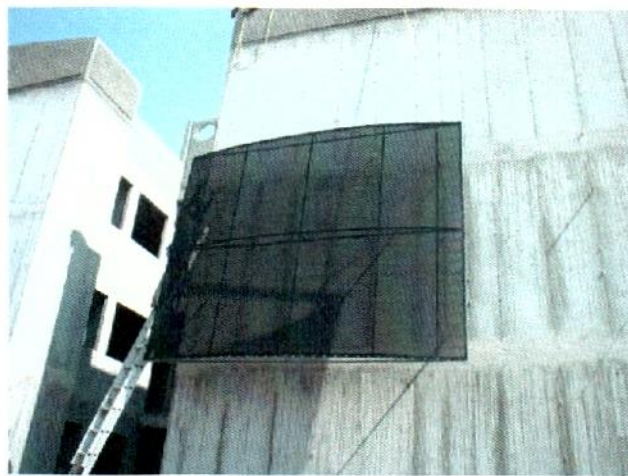
Figura 3.48 El dispositivo colocado en el muro.
