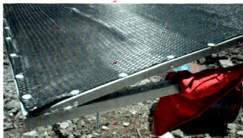
Figura 3.28 Se observa el tipo de fijación de la malla sombra a la estructura, a base de remaches.
