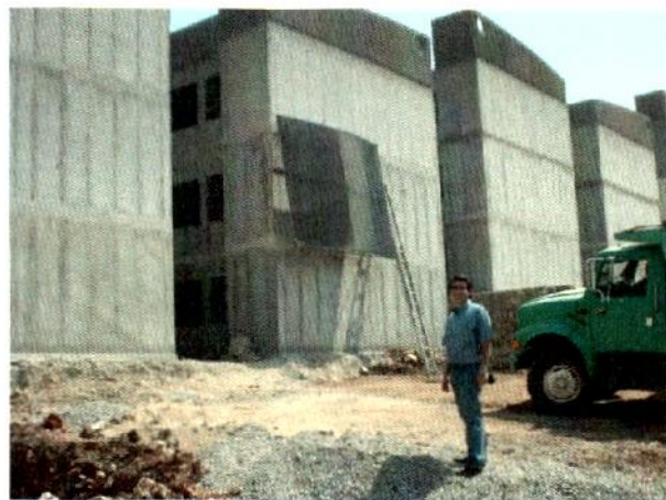
Figura 3.50 Una vista del edificio completo.
