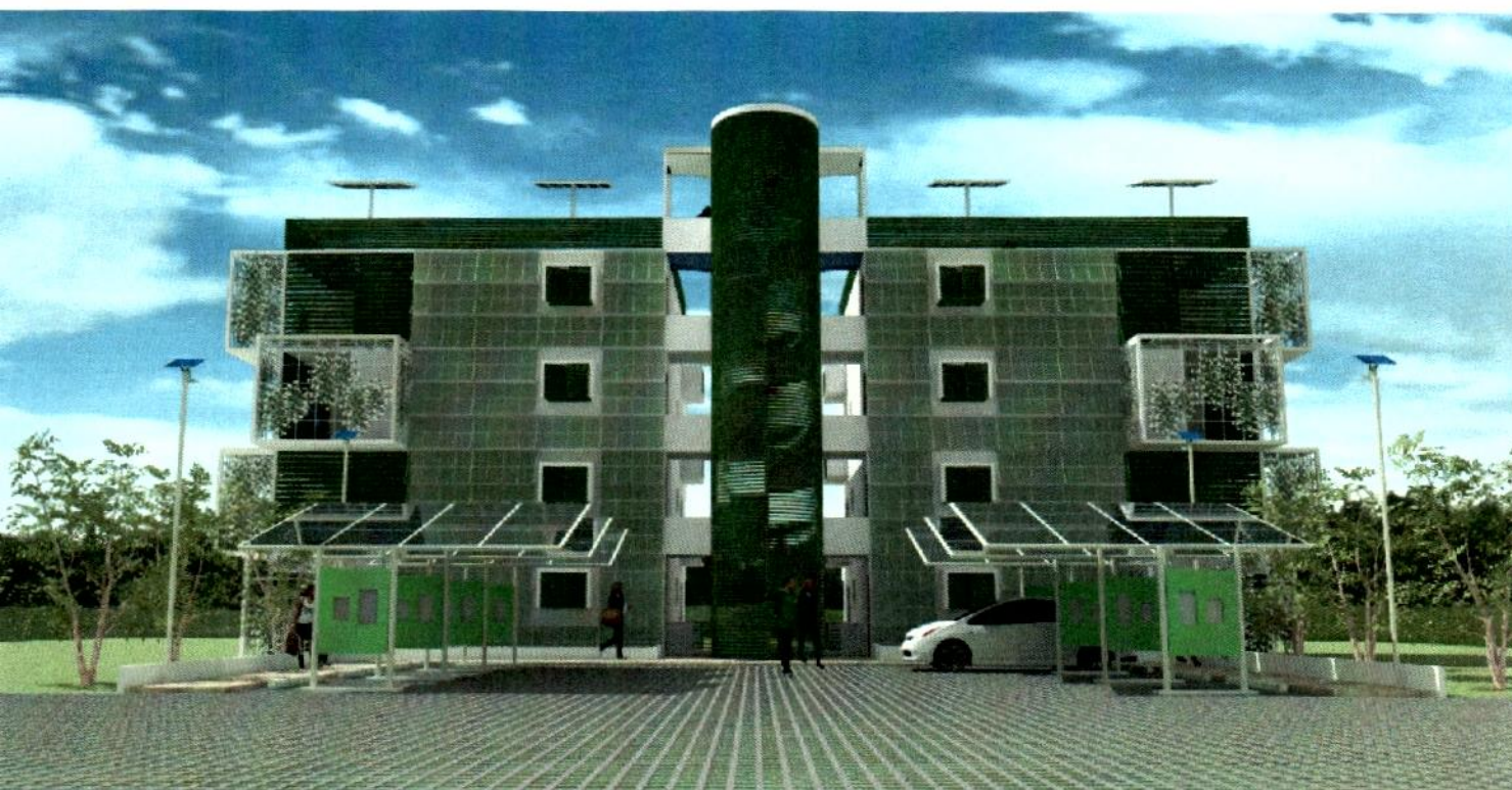
Figura 7.20 La fachada sur.
