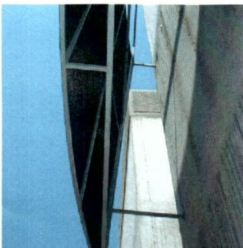
Figura 3.45 Se muestra la estructura fijada al muro, vista desde abajo.
