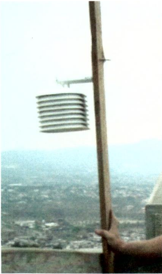
Figura 3.61 Se observa la carcasa que contiene en su interior al registrador HOBO 5.
