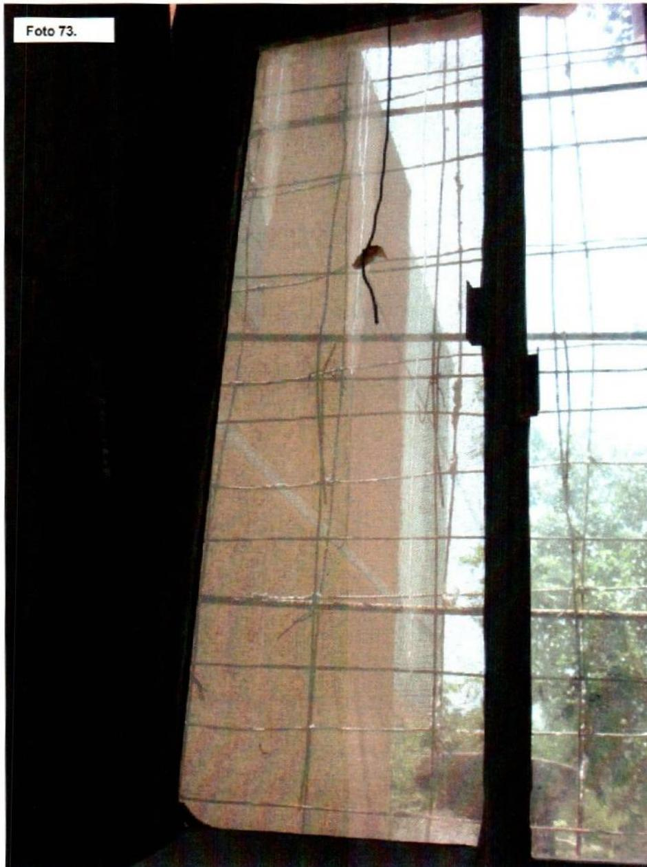
Foto 73. Esta foto, muestra claramente el funcionamiento en acción del dispositivo, cómo va mojándose y luego el viento penetra por la ventana para realizar el "Enfriamiento evaporativo". Captado por los instrumentos de mediciones. (Ver Gráficas Cap. 5).
