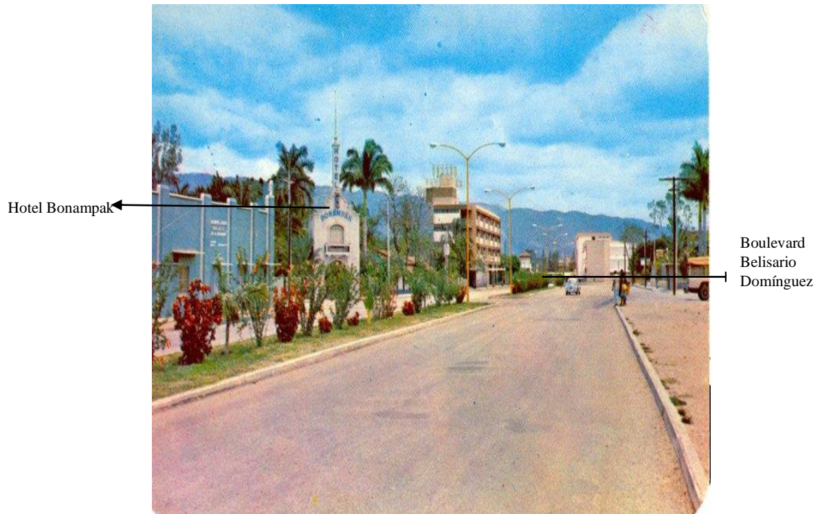
Imagen 15. Obras de ampliación del Boulevard Belisario Domínguez en 1950
