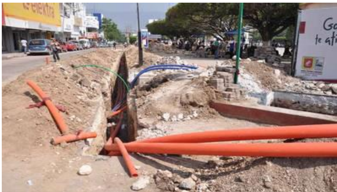
Imagen 31. Obras de remodelación de la Plaza Cívica, 2017
