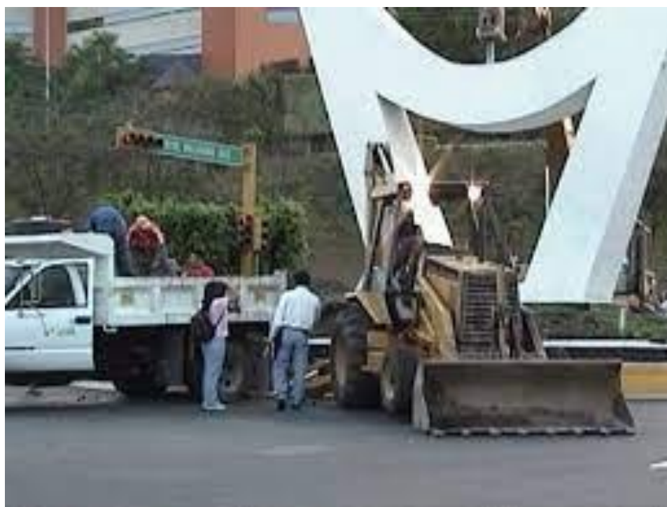
Imagen 25. Derribo de la fuente de Mactumatzá
