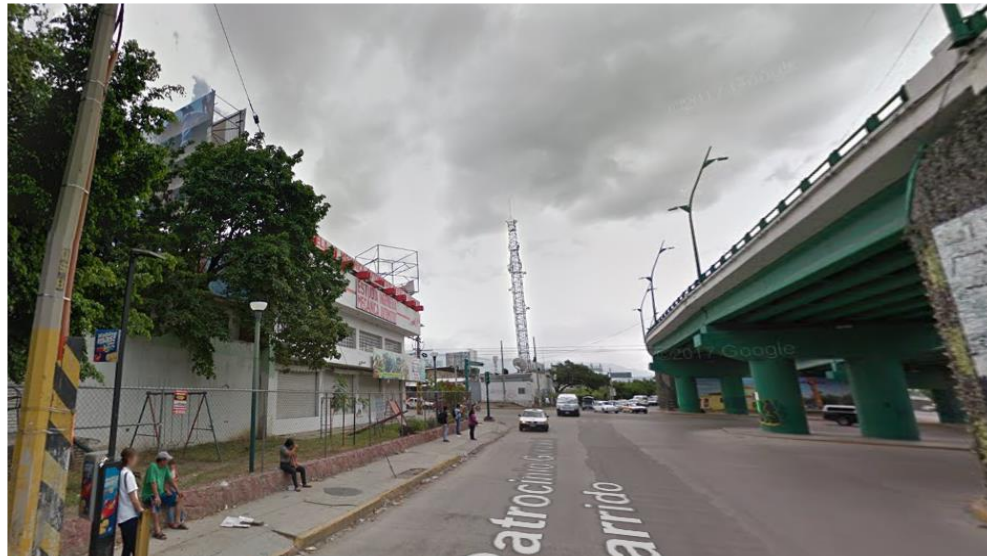
Imagen 21. Mobiliario del parque lineal y área verde Calzada el Sumidero
