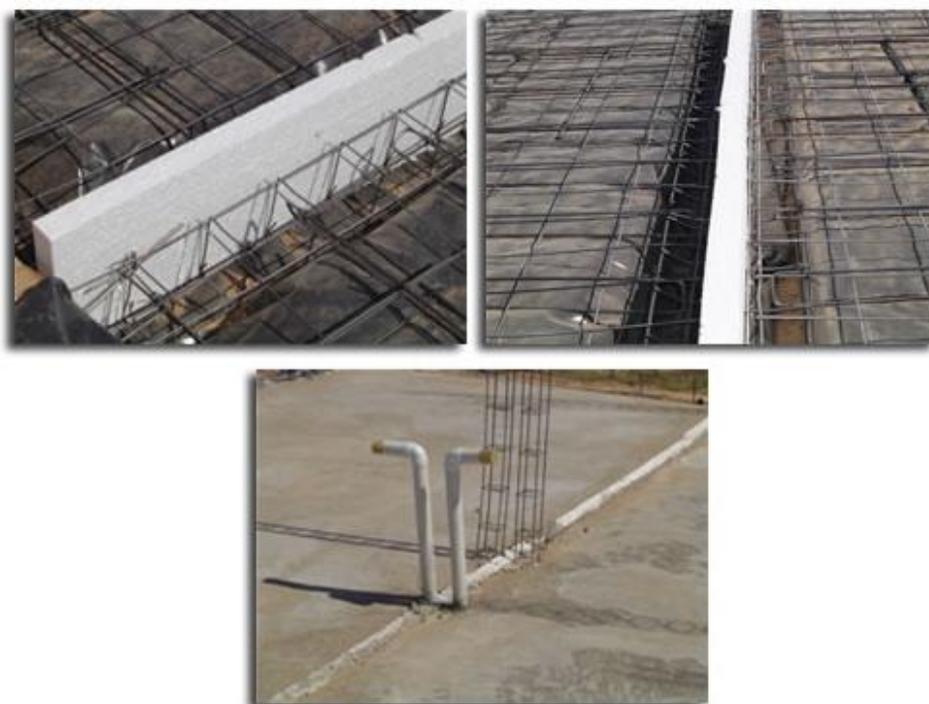
**Nota:** En las construcciones de viviendas en serie, como las construidas en el Fraccionamiento Nuevo Huehuetán I, se utilizaron placas de poliestireno para desligar las paredes de las viviendas y así evitar golpes por sismos, paso de ruido, vibraciones y humedad. Fuente: (MG, 2021)
