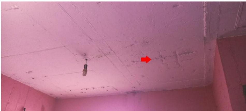
**Nota:** La segregación presentada en la losa de las viviendas del Fraccionamiento Nuevo Huehuetán I, representa una de las afectaciones más usuales en la construcción de viviendas de interés social, que al no ser tratadas de manera adecuada afecta significativamente la resistencia y durabilidad de la estructura. Fuente: Investigación propia.
