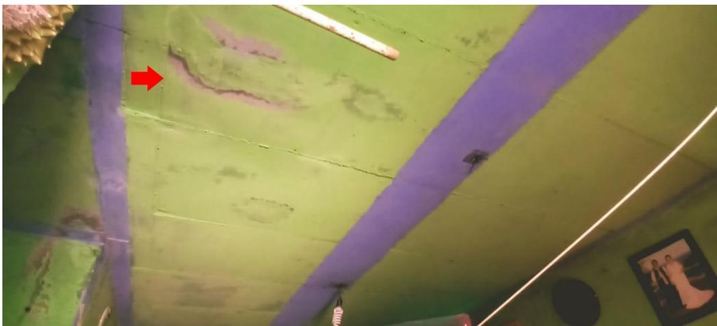
**Nota:** La corrosión de acero de refuerzo al no ser tratado, implica un alto riesgo de falla de la estructura y/o una gran inversión en mantenimiento. Fuente: Investigación propia.
