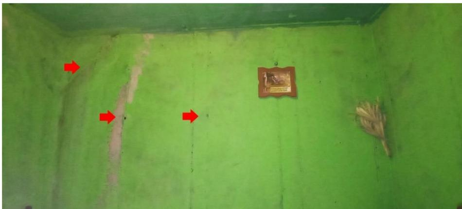
**Nota:** Al interior de las viviendas se aprecia humedad en las paredes de concreto, causado por el agua que se filtra a través de huecos y fisuras, producto de las diversas instalaciones (eléctricas e hidrosanitarias en las paredes). Fuente: Investigación propia.
