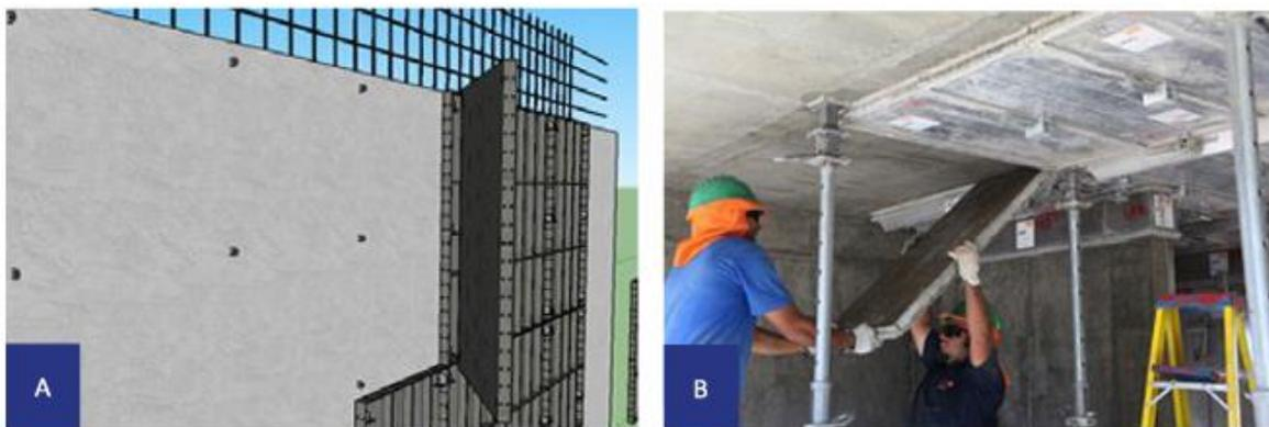
**Nota:** Se puede observar que, al descimbrar y retirar los elementos de fijación y separación de la cimbra metálica, quedan huecos que deben ser rellenados con mezcla de mortero, Fuente: (FICEM-FIHP, 2018)
