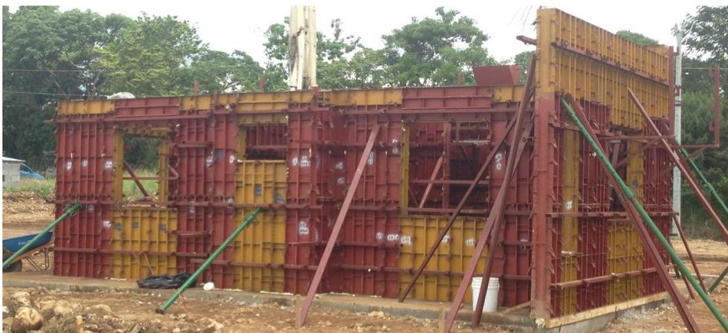
**Nota:** El uso de formaletas y/o cimbras metálicas en la construcción de viviendas en serie facilita la construcción de estas, acortando el tiempo de producción, pero comprometiendo la calidad constructiva. Fuente: (S.A.S., 2017)
