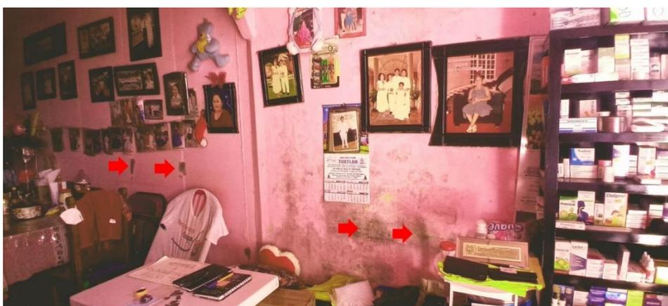
**Nota:** Al interior de las viviendas se aprecian huecos que se han dejado para poder fijar la cimbra y/o formaleta para el colado monolítico de las paredes de concreto, estos ocasionan filtración de agua y humedad a pesar de que los habitantes han intentado resanar estos huecos con mortero al interior de la vivienda. Fuente: Investigación propia.
