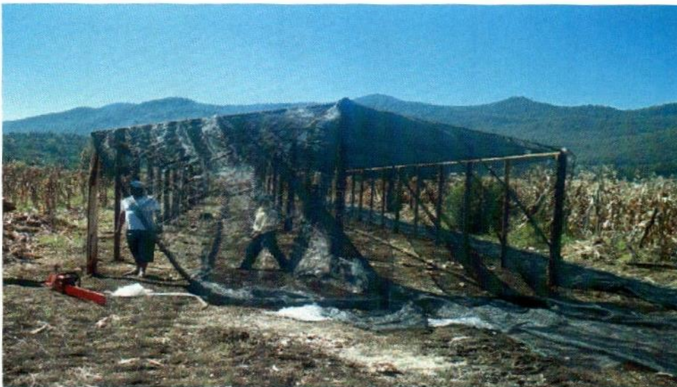
Imagen 16. Construcción del Vivero Clonal
