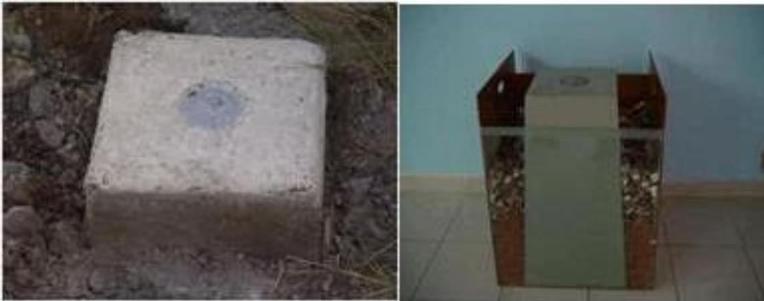
Figura 4.3. Mojones de concreto hidráulico establecidos por las normas del INEGI.
