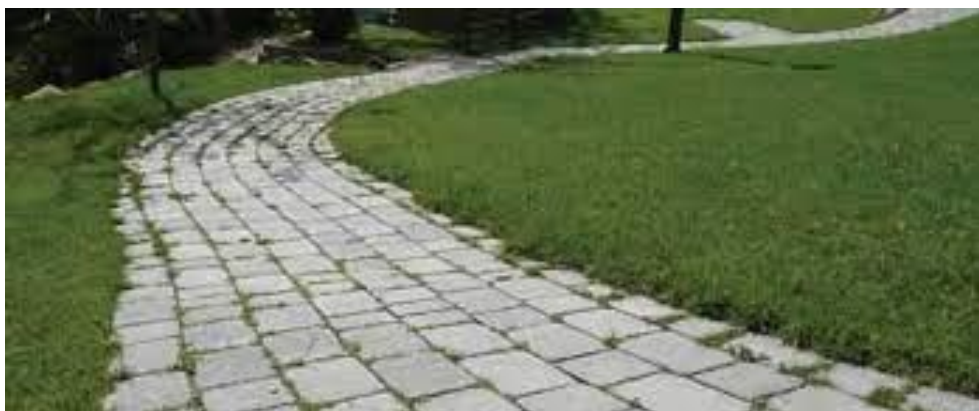
Figura 24 Colocación de adoquines en el andador peatonal
