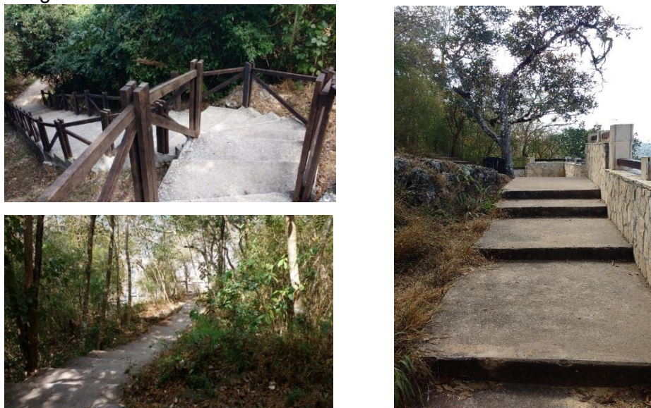
Figura 11 Infraestructura en el mirador El Roblar PNCS Fuente: Fotografía propia
