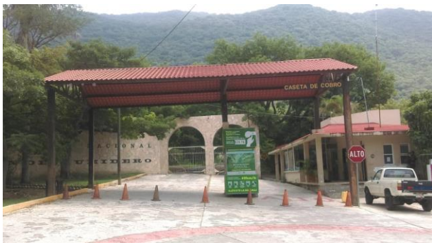
Figura 7 Caseta Operativa de control turístico PNCS Fuente: Fotografía propia
