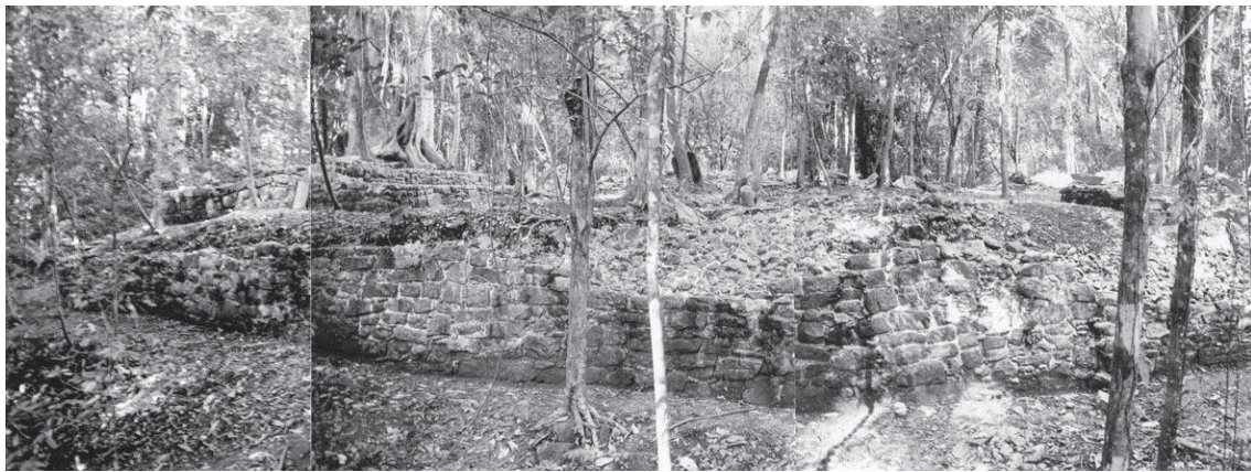
Foto 5.5 Muros de contención del basamento general del Grupo 30.
