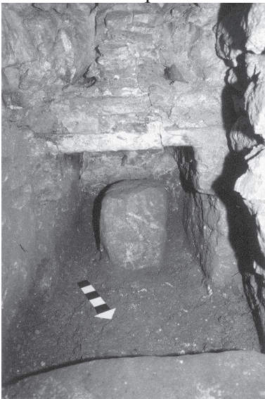
Foto 5.32 Banca con nicho y altar cilíndrico. Subestructura del edificio 15.
