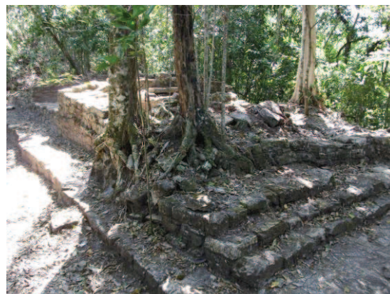
Foto 5.17 Edificio 20 en la cima de la Acrópolis.
