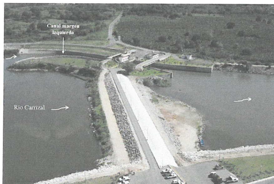
Imagen 3.2.- Vista panorámica de la Cortina de la Estructura de Control El Macayo.
