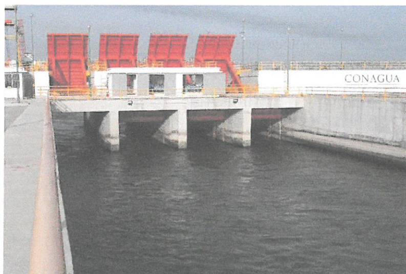
Imagen 3.4.-Vista aguas abajo del canal de la margen derecha.
