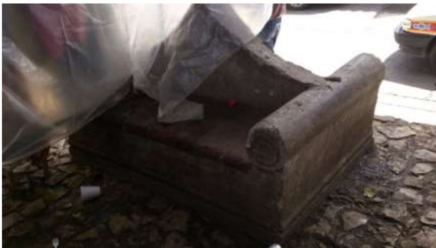
Fotografía 30 Banca Histórica perteneciente a la Alameda Utrilla; Foto tomada por Cordero; mayo del 2013
