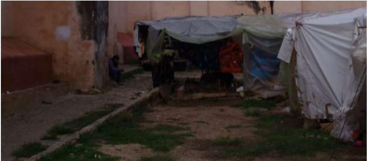
Fotografía 19 Jardineras en mal estado, generación de espacios muertos; Foto tomada por Cordero mayo de 2013
