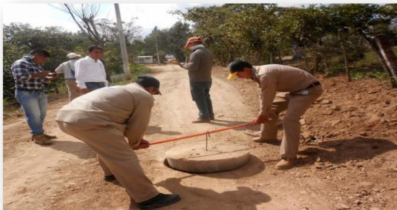
Imagen 54. Verificación física en obra de alcantarillado, nótese la brigada propuesta e idealizada, cuando se presenten auditorías.
