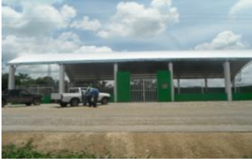
Imagen 23. Cancha de usos múltiples construida con recurso del ramo 33
