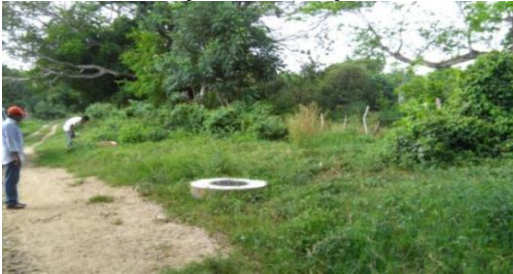
Imagen 6. Emisor del Sistema de Alcantarillado de la Colonia Democrática Chiapaneca, Tonalá, Chiapas.
