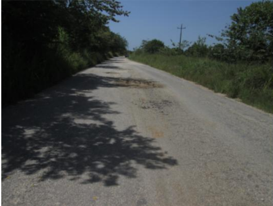
Imagen 11. Vista panorámica del estado físico en la verificación física de la obra.
