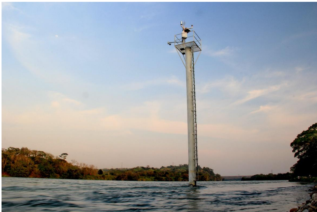
Ilustración 1. Estación Hidrométrica Automática Peñitas.
