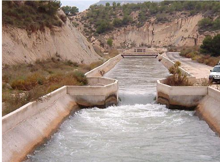
Ilustración 6. Aforador de garganta larga.
