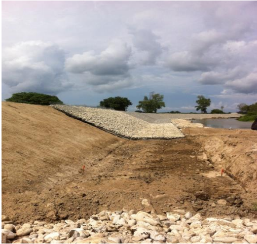
b) Excavación y relleno de trinchera
