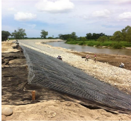
c) Relleno de gaviones
