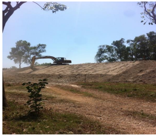
e) Protección de talud seco
