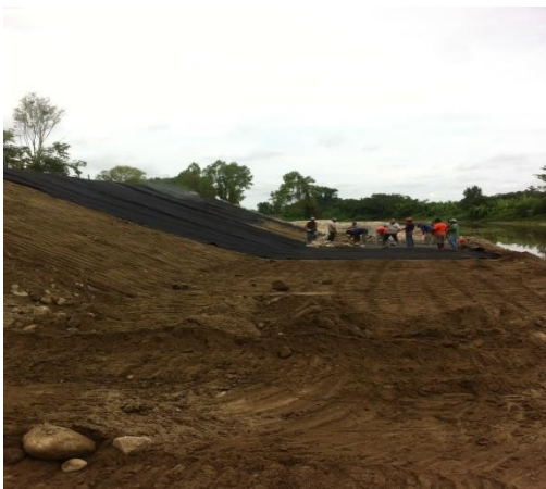
d) Colocación de geotextil
