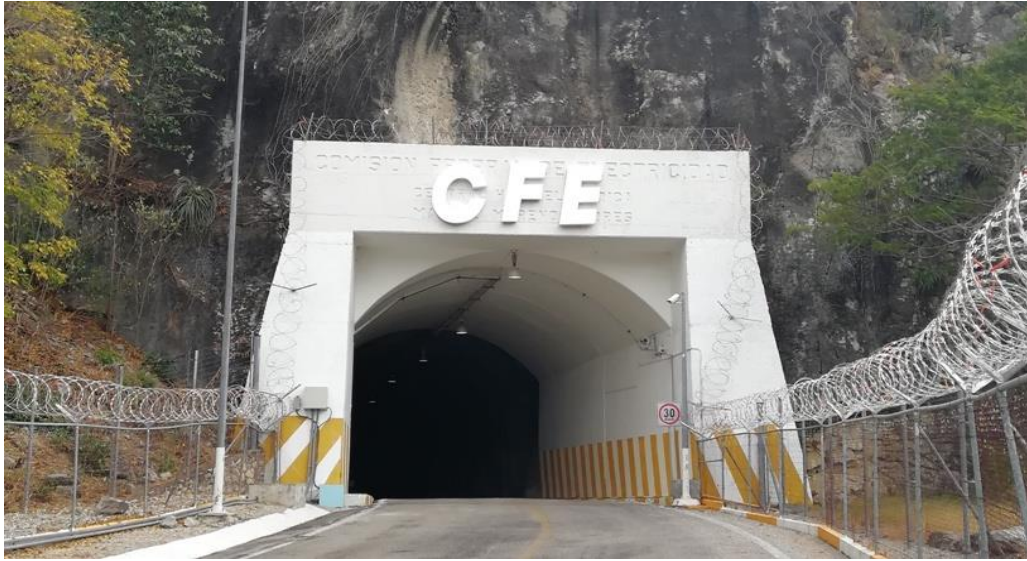
Figura 4.16.- Túnel de Acceso a Casa de Máquinas de la Central Fuente: Diseño Propio
