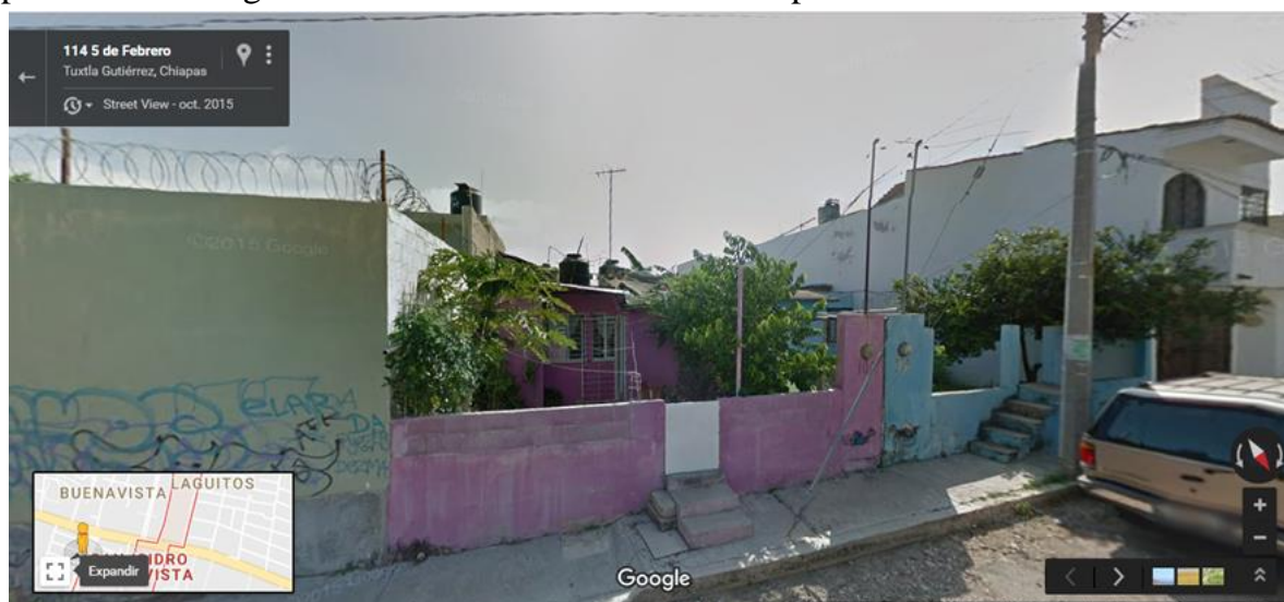
Apéndice 23. Imagen 2 de adecuaciones de viviendas para contener inundaciones.
