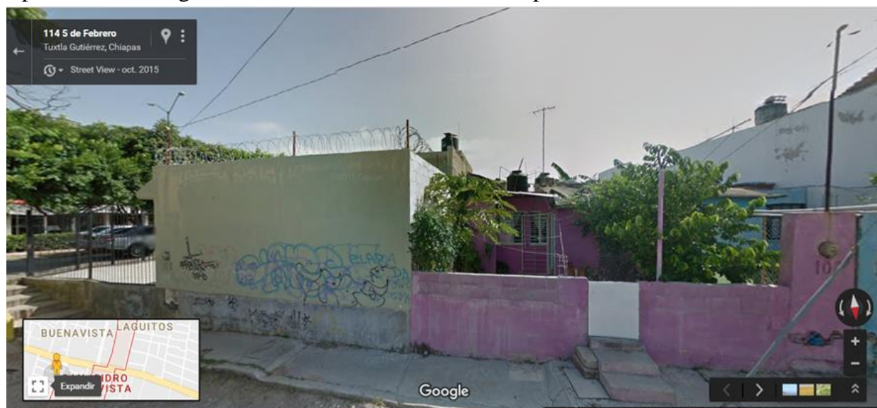
Apéndice 22. Imagen 1 de adecuaciones de viviendas para contener inundaciones.
