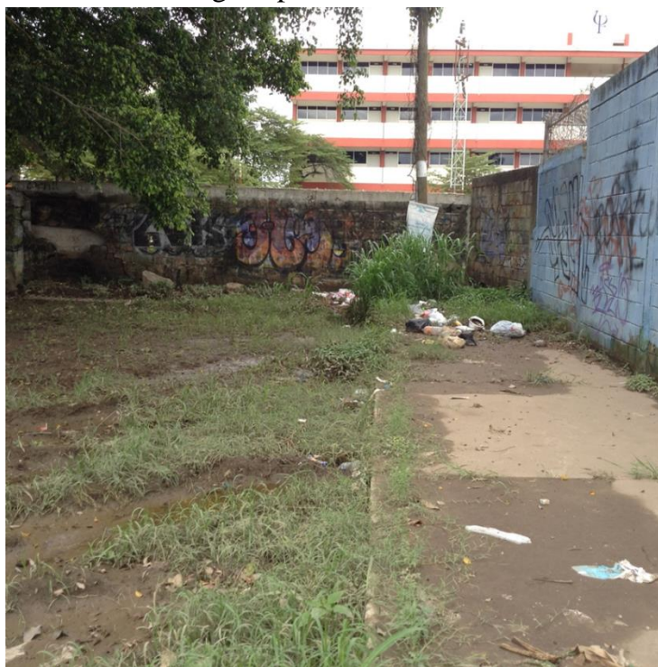
Apéndice 26. Imagen de delimitación física de terreno adyacente de la UPSUM, donde se desfogaban de manera natural las aguas pluviales.
