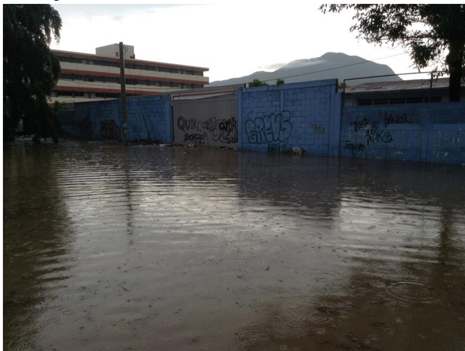
Apéndice 13. Imagen 1 de inundaciones en la sección oriente del fraccionamiento.
