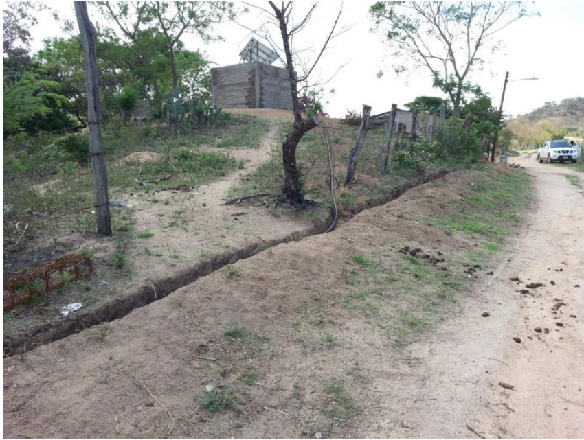
Imagen 34. Vista de El Tuzal. Al fondo se observa el tanque de almacenamiento de agua y el sistema fotovoltaico.
