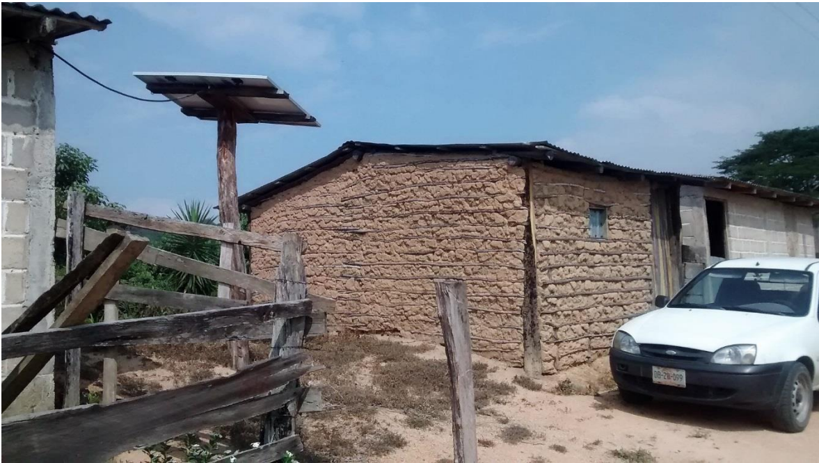
Imagen 55. vivienda con sistema fotovoltaico en El Tuzal
