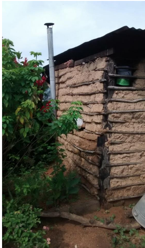
Imagen 51. Parte Exterior de una cocina en El Tuzal
