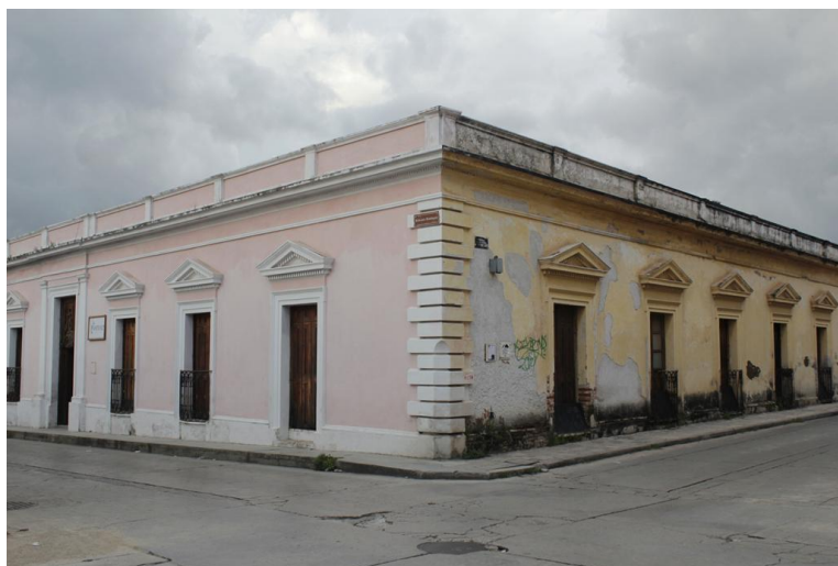
Imagen 20. Fachada en remodelación del espacio La Enseñanza , espacio de difusión cultural donde se realizan periódicamente exposiciones, octubre 2013.
