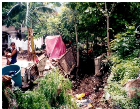
Foto 15. Vivienda en zona de riesgo
