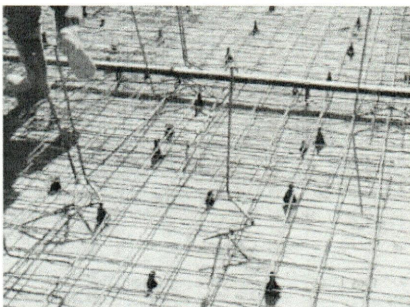
Figura 33. Armado de la Cimentación
