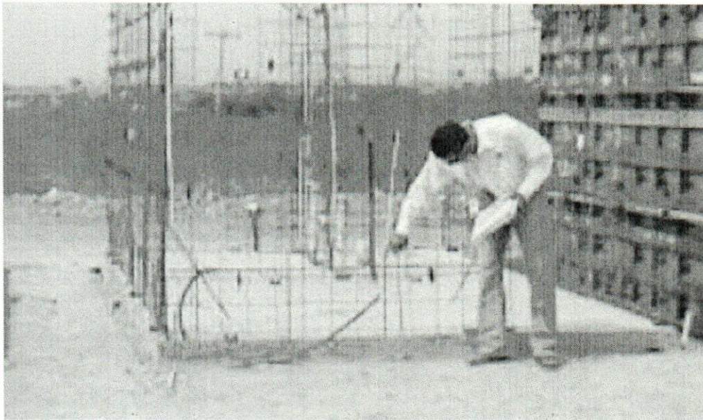
Figura 39 Acero en muros
