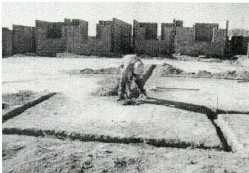
Figura 30. Excavación de cepas
