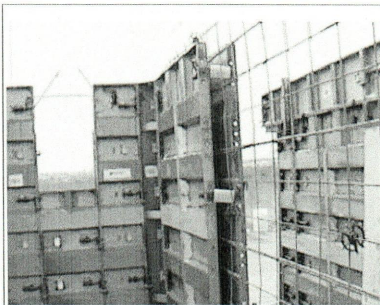
Figura 44 Armado de la cimbra del molde
