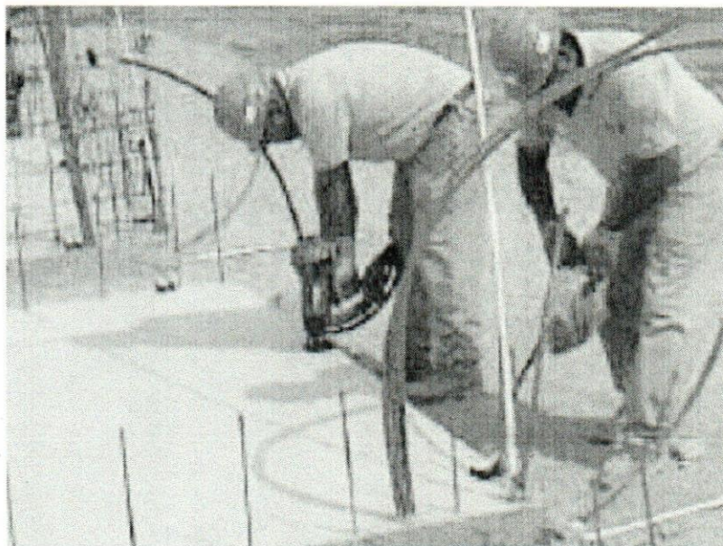
Figura 38. Colocación de la "U" de tope
