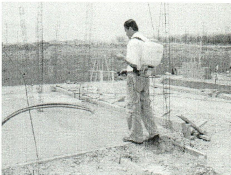
Figura 36. Aplicación de la membrana de curado.
