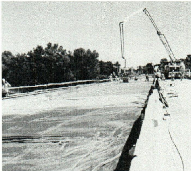
Figura 13. El curado debe empezar en cuanto el concreto se endurezca suficientemente para prevenir la erosión de la superficie. El yute (arpillera, estopa) rociada con agua es un método efectivo para el curado húmedo.
