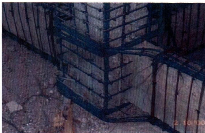
Figura 51: Detalle de refuerzo en unión columna-contratrabe (Aguilar Carboney, Jorge, 1995)
