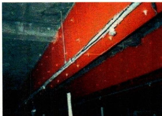
Figura 28: Encamisados con placas de acero en vigas
