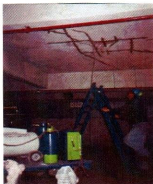
Figura 34: Método con inyección de losa
