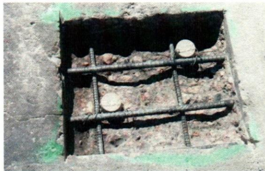
Figura 43: Protección catódica de una superficie de concreto
