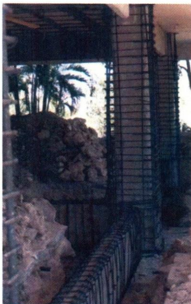
Figura 50: refuerzo de columnas y contratraveses (Aguilar Carboney, Jorge, 1995)
