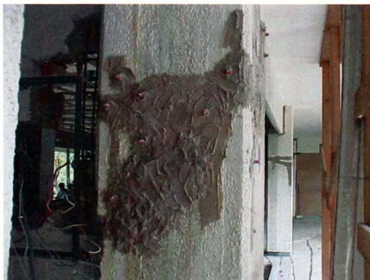
Figura 49: Inyección de grietas (Aguilar Carboney, Jorge, 1995)
