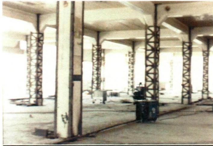
Figura 29: Refuerzo de columnas con perfiles de acero
