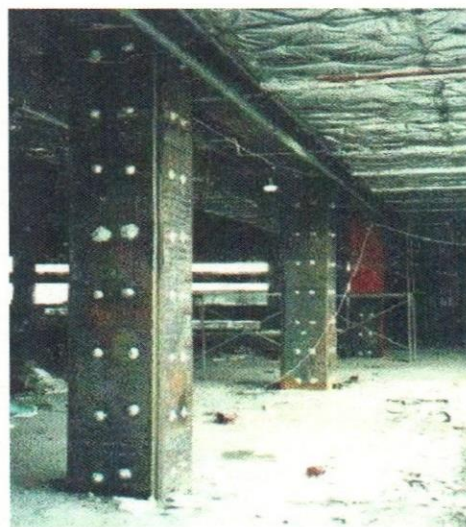
Figura 27: Encamisados con placas de acero en columnas
