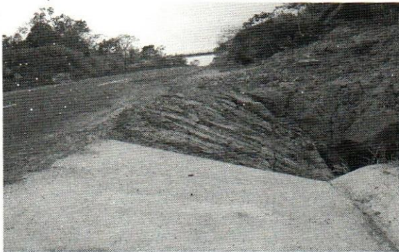
Figura II.13. Cuneta triangular de concreto hidráulico
