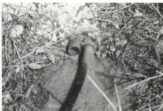
Figura III.9. Limpieza de Subdrenaje
