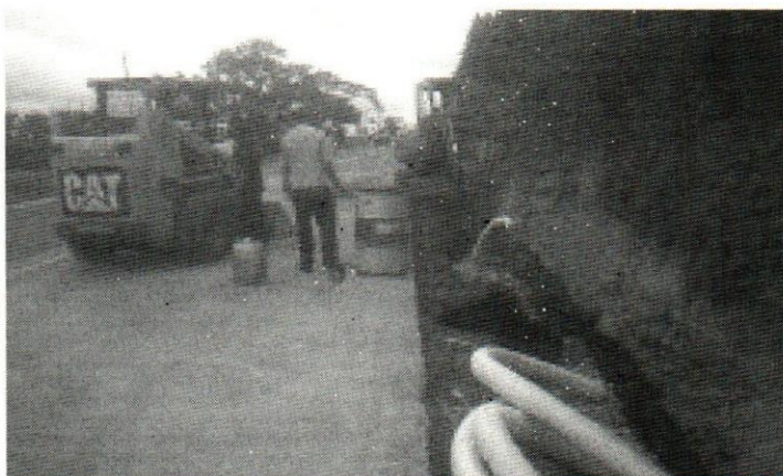
Figura III.26. Reposición de Subdrenaje
