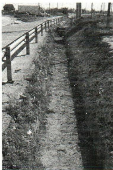
Figura III.3. Limpieza de canales
