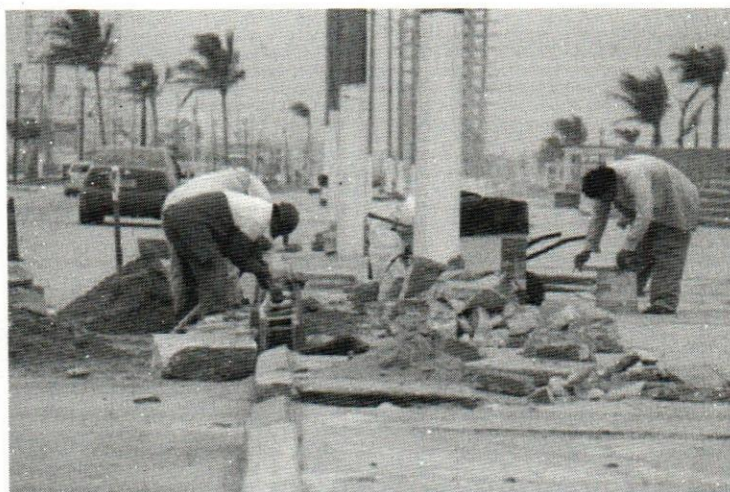
Figura III.17. Reposición de Guarnición
