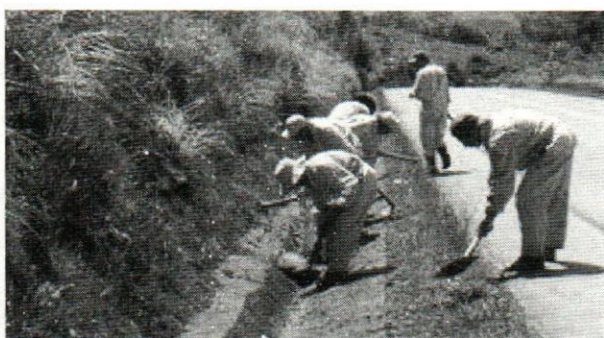
Figura III.1. Limpieza de Cuneta Lateral
