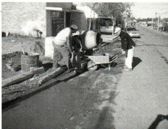
Figura III.22. Reposición de Cunetas
