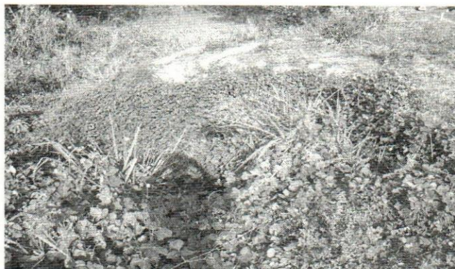
Figura II.12. Uso de pasto para proteger el talud
