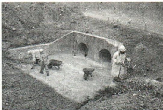
Figura III.5. Limpieza de Alcantarillas
