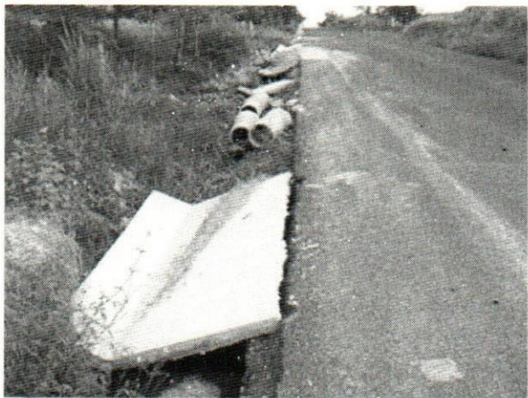
Figura III.21. Cunetas Destruídas
