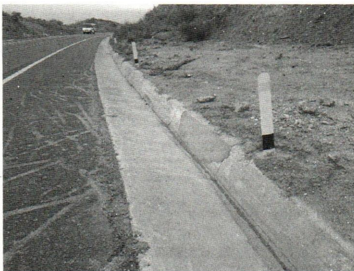
Figura III.14. Reparación de cunetas
