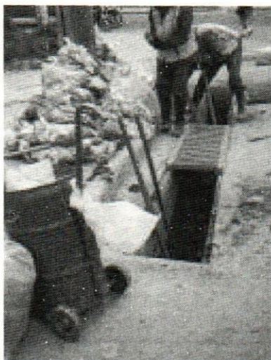
Figura III.12. Limpieza de Rejillas
