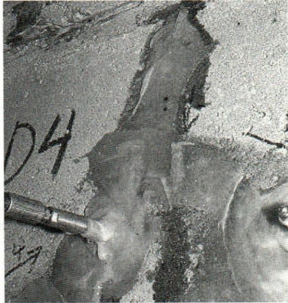
Figura III.19. Sellado de Grietas
