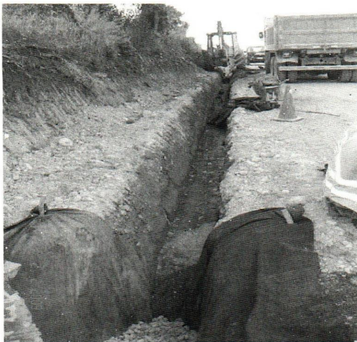
Figura III.20. Reposición Aislada de Subdrenes
