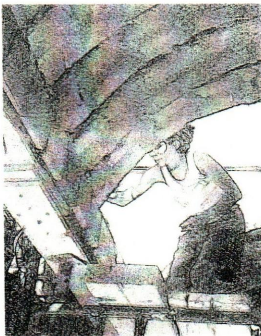
Ilustración 28 Bóvedas de ladrillo armado Carlos González Lobo viviendas de bajo costo
