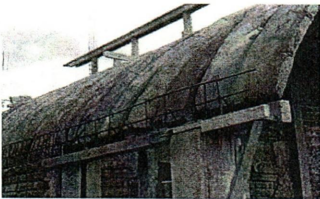
Ilustración 284 Detalle de muro perimetral y cadena donde se asienta el sistema
