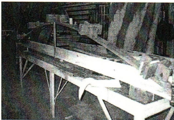
Ilustración 156 Etapa de fabricación de las vigas arco.
