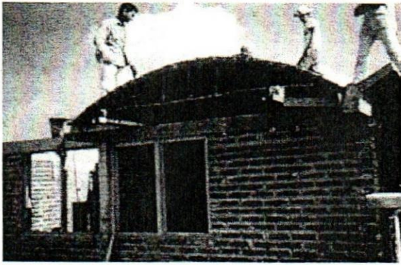
Ilustración 182 Proceso constructivo, elaboración del sistema
