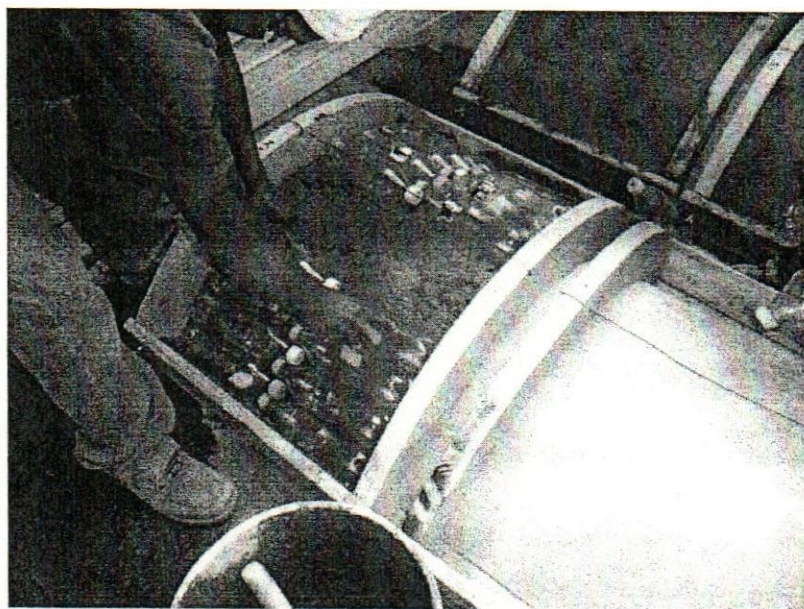
Ilustración 654 Colocación de Botellas de Pet 600 ml. Con las tapaderas hacia el centro para generar a través de esta mayor concentración de mortero. Previo se coloca una capa de mortero cemento arena sobre molde en forma de bóveda de 0.2 cm. De espesor.
