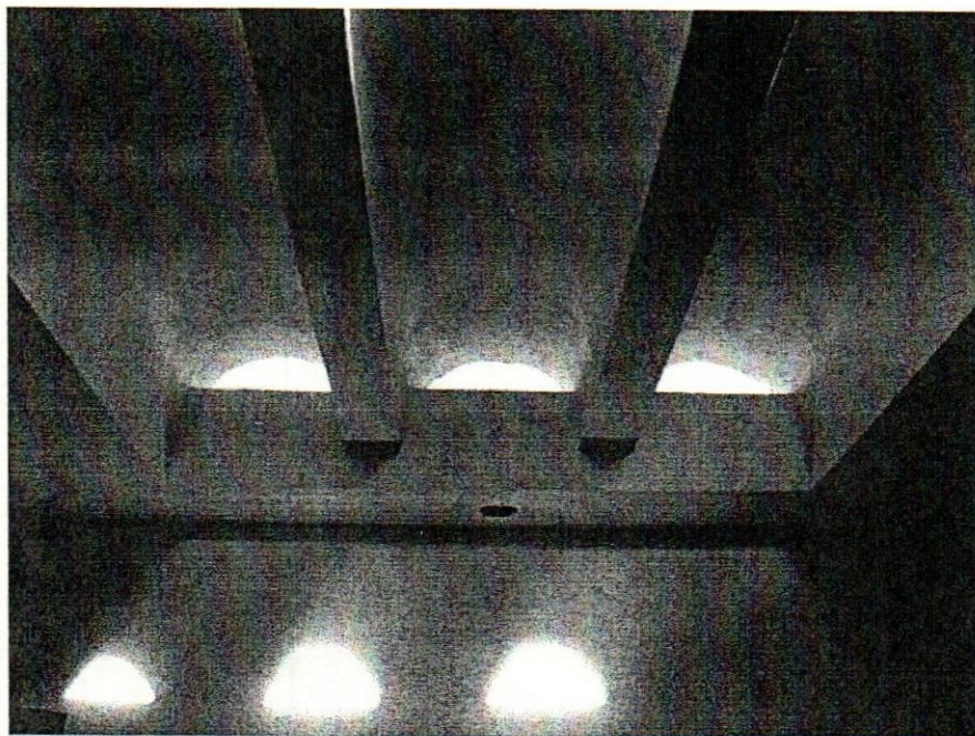
Ilustración 86 Vista del interior de la habitación Adaptación de los techos alternativos con un coronamiento de losa de concreto armado
