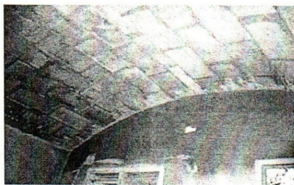
Ilustración 226 Interior de una vivienda
