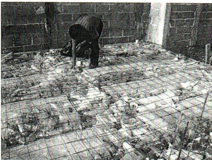
Ilustración 641 Colocación de malla electro soldada para piso para posteriormente procesar la losa de compresión, previo se colocan Botellas de pet compactadas para generar una superficie plana.
