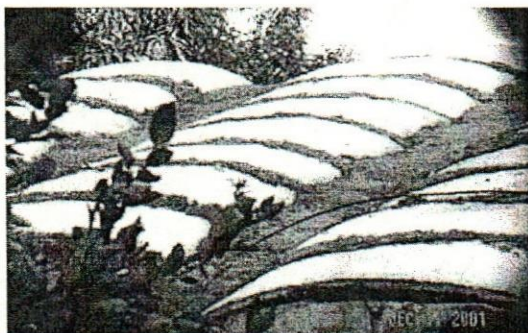
Ilustración 362 configuración total de la bóveda Carpanel
