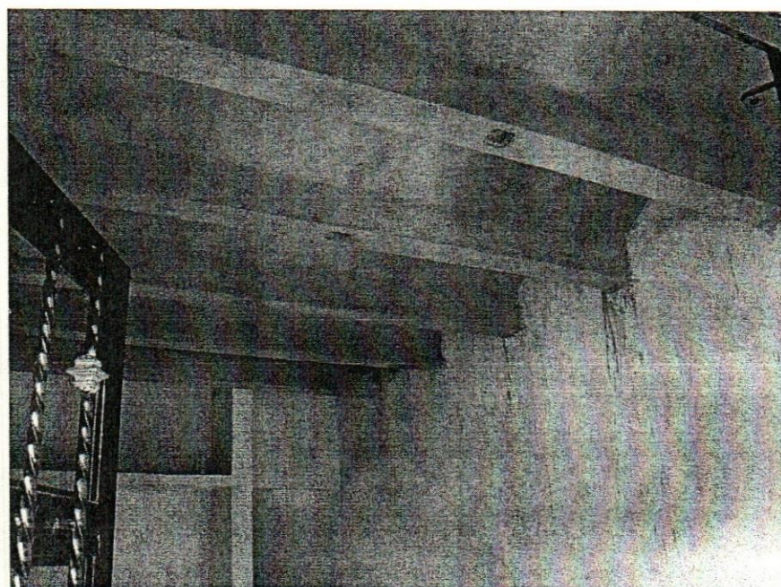
Ilustración 754 Aspecto de techo alternativo con acabado esponjeado fino.
