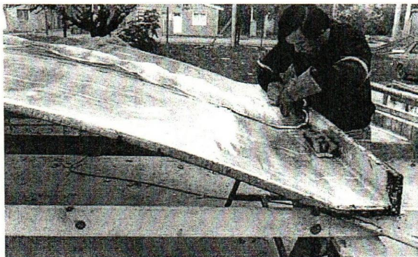
Ilustración 100 Terminación superficial con aislamiento hidrófugo mediante membrana asfáltica con aluminio.
