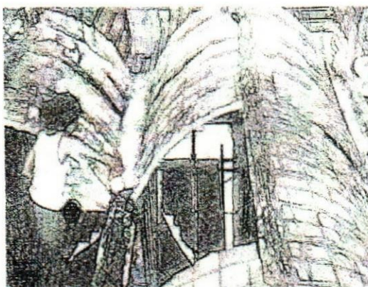
Ilustración 23 Bóvedas de ladrillo armado Carlos González Lobo viviendas de bajo costo
