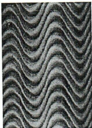
Figura 3.1: Acabado con relieves mediante patrones y forros.
