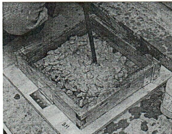
Figura 5.14 Varillado del concreto
