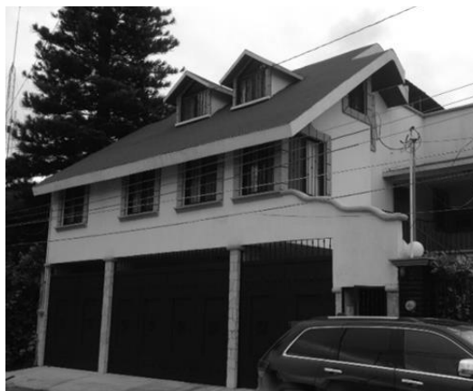
Figura 7 Fachada Villas Cruztón
