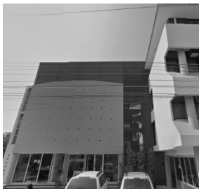
HOTEL RS Suites Blvd. Presa Chicoasen 815 Col. Electricistas las Palmas.
