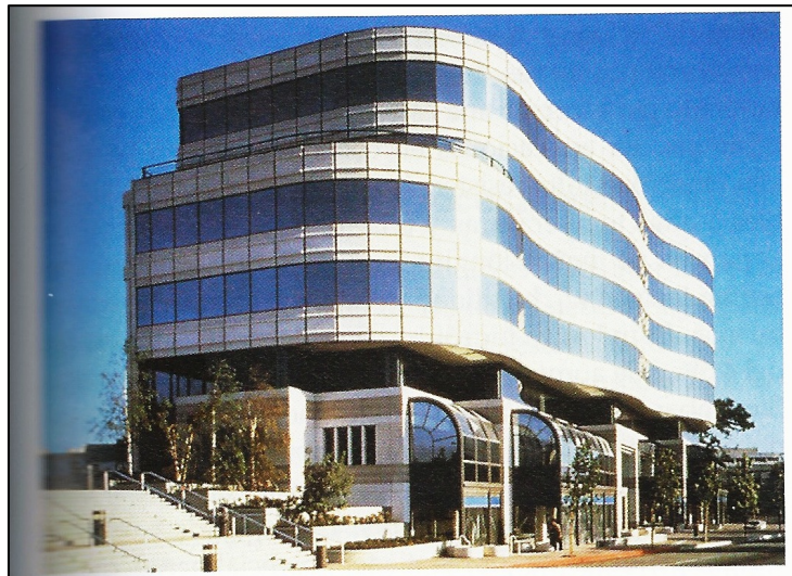
Figura 1. Los paneles de concreto reforzado con fibras de vidrio son ligeros y suficientemente fuertes para reducir los requisitos estructurales de este edificio. (Kosmatka, 2004)
