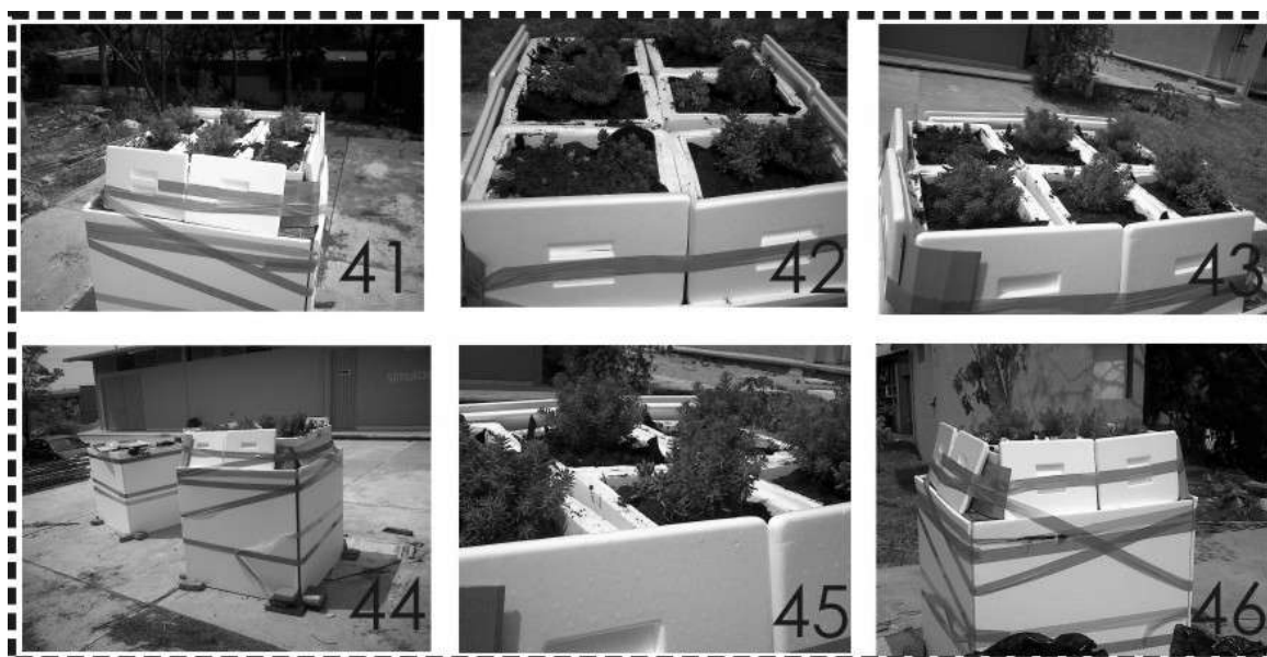
Fotos (41-46): Colocación de Sombra alrededor de los contenedores para evitar incidencia térmica mediante conducción. Realizado in situ por el autor.
