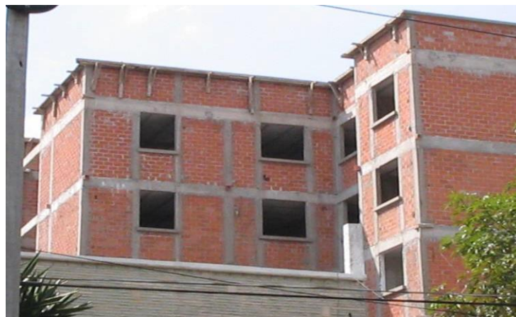
Figura 2.7 Modelo construido de acuerdo N.T.C.M. (GDF, 2004 Tomo I), Tomado de 6º simposio nacional sobre ingeniería estructural en la vivienda, L. Flores, (2009).
