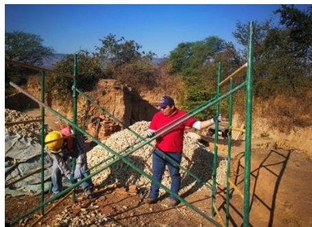
Figura 5.16 colocación de andamios. Fuente: Propia del autor.
