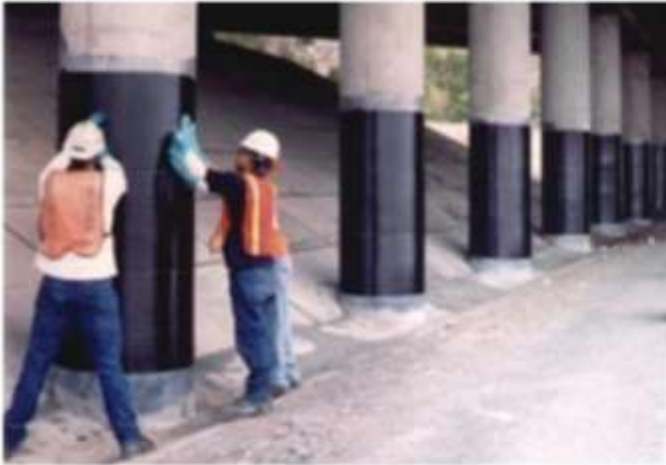
(a) Columnas de puente reforzadas con fibras de carbono
