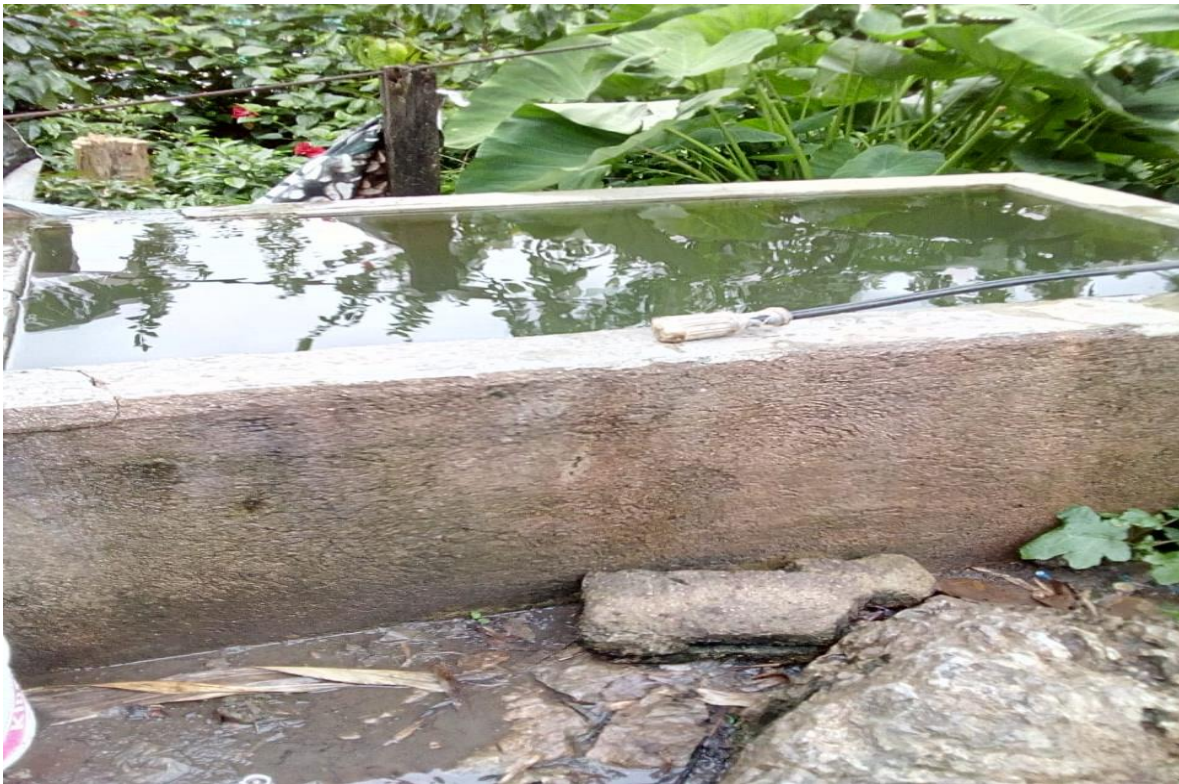
Fotografía 1. Tanque de concreto ubicado en el patio de una de las viviendas en el ejido Mérida.
