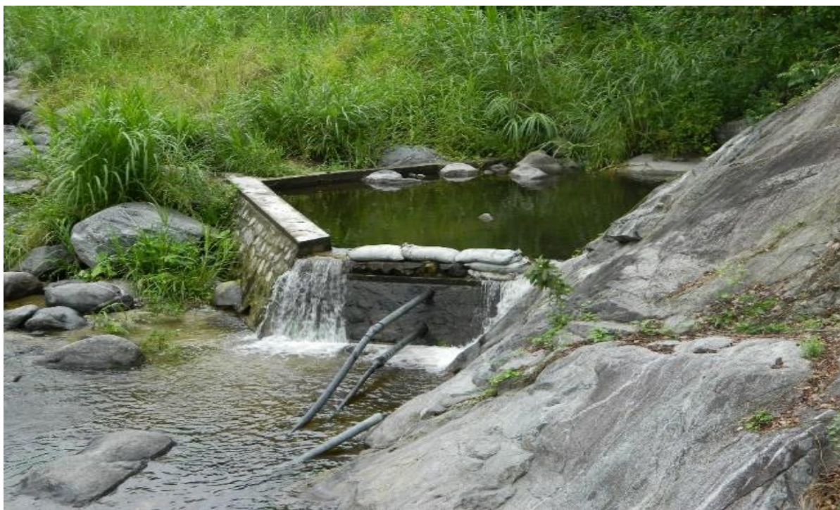
Figura 9 Obra de captación existente
