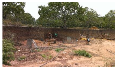
Figura 13. Ladrillera "los Mangos".
