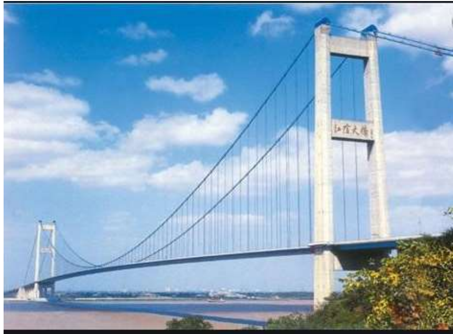
Figura 17: Puente colgante Jiangyin, Jiangyin China (1994-1997)
