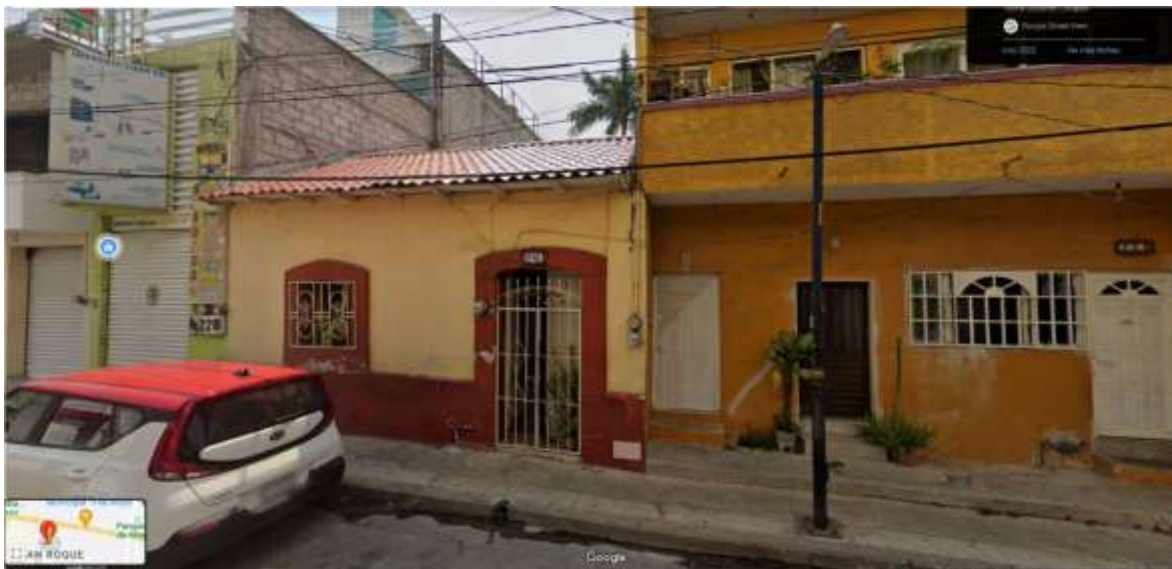
Imagen 4.6 En esta imagen podemos observar el techo tradicional de dos aguas, de material adobe y la fachada Tradicional de una puerta y una ventana de la casa de la señora C, incluso conserva la puerta de cuatro hojas original con la que compraron su casa en 1952, la señora Conchita piensa que su casa debe tener más de cien años por el tipo de puerta que tiene. Al rededor podemos notar las construcciones nuevas que incluyen la puerta sobre las escaleras y no ligeramente hundidas Fuente:Google Maps Streetview.
