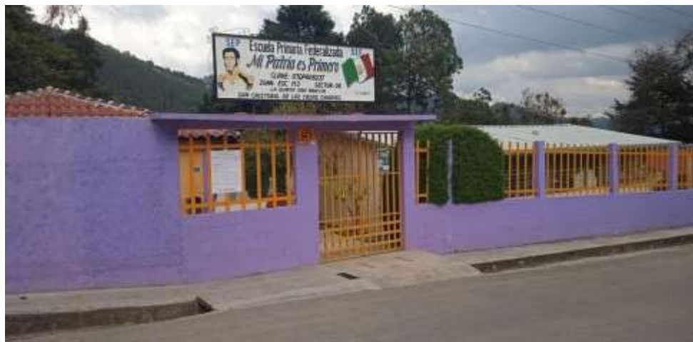
Fachada de la escuela primaria multigrado, noviembre 2021.
