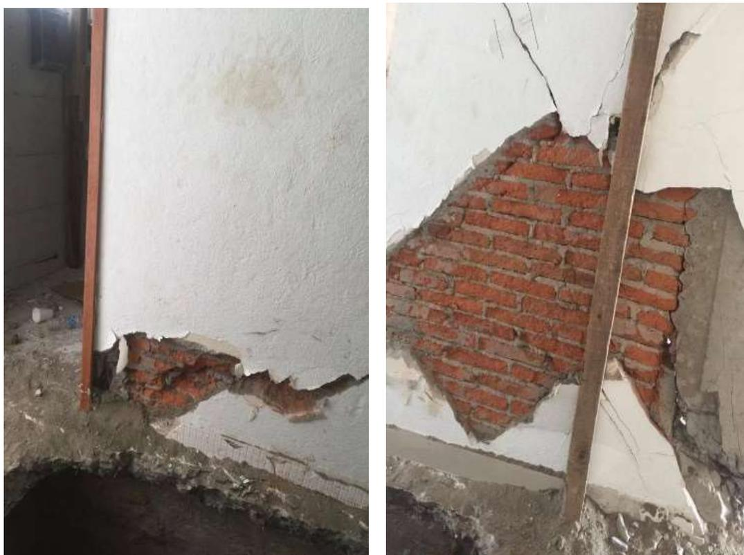
*Figura 16. Daño en Muro Planta Baja Eje B-3.*
