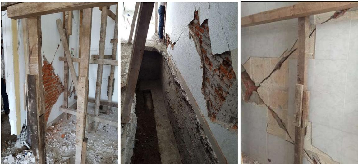
Figura 81. Falla de Muro del eje “C” planta baja y alta ( $V_u > V_R$ ).
