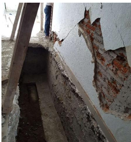
*Figura 26. Verificación de existencia de cimentación de acuerdo a planos estructurales.*
