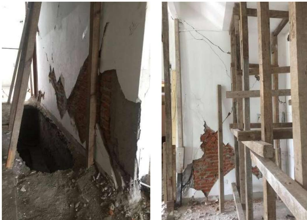
*Figura 17. Daño en Muro Planta Baja Eje B-4.*
