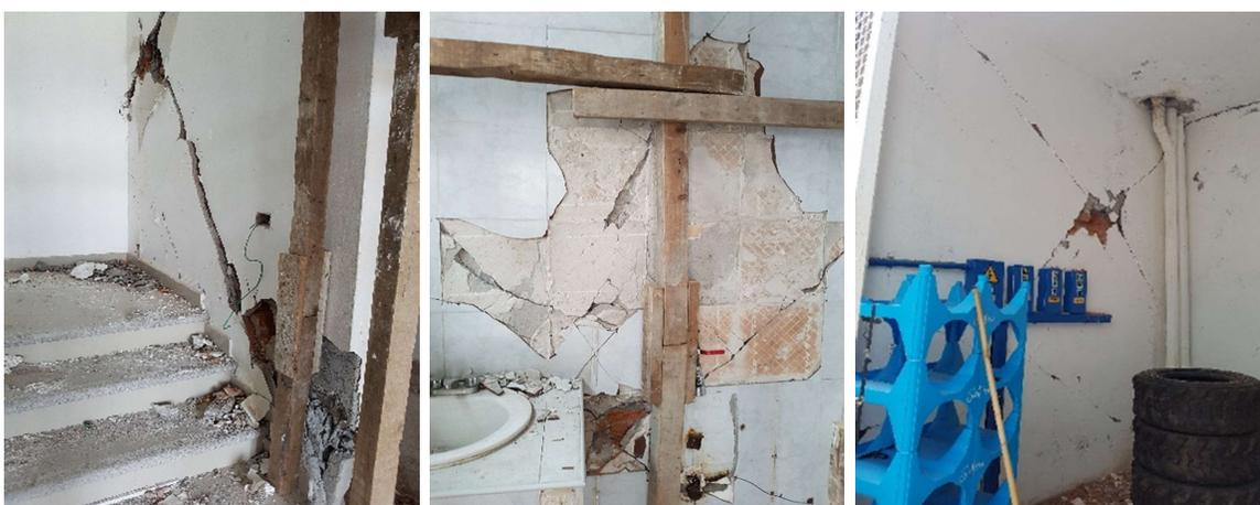
*Figura 25. Daño en muros debido a fuerzas cortantes actuantes mayores a las resistentes.*
