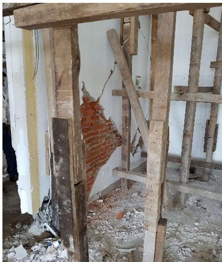
*Figura 27. Aplastamiento de concreto en los elementos confinantes de los muros.*
