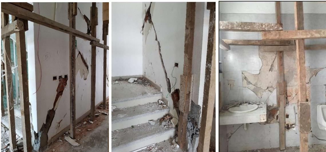
Figura 83. Falla de muro del eje "D" planta baja y alta ( $V_u > V_R$ ).
