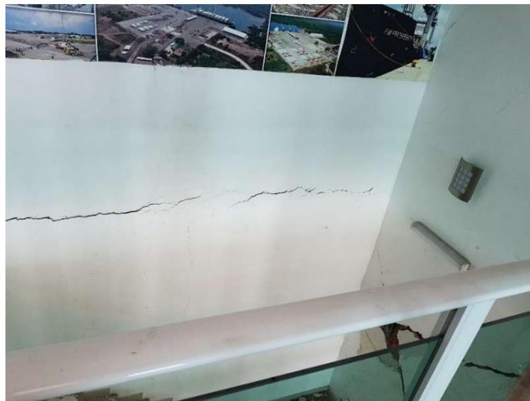
Figura 87. Falla de muro entre eje a y 3 (escalera) planta baja y alta.
