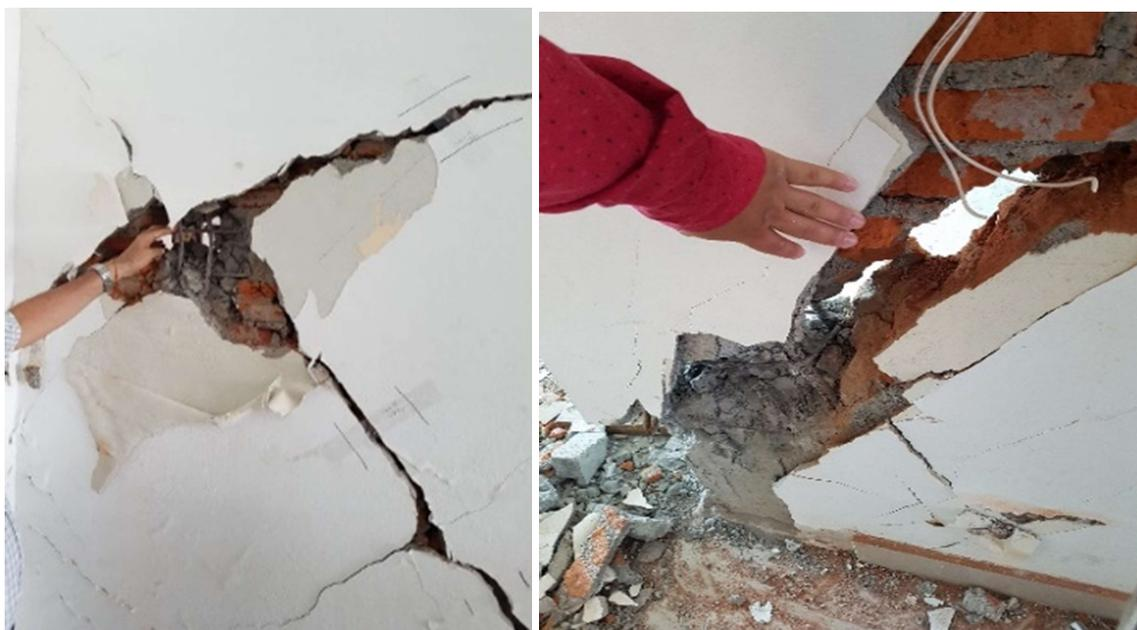
*Figura 23. Daño en muro de mampostería, se observa acero de confinamiento muy separado.*
