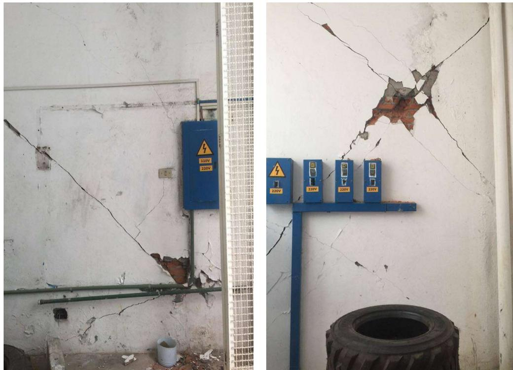
*Figura 18. Daño en Muro Planta Baja Eje D-C-3.*
