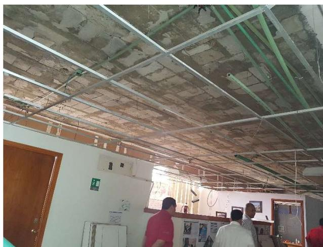
*Figura 29. Losa Reticular de Azotea.*
