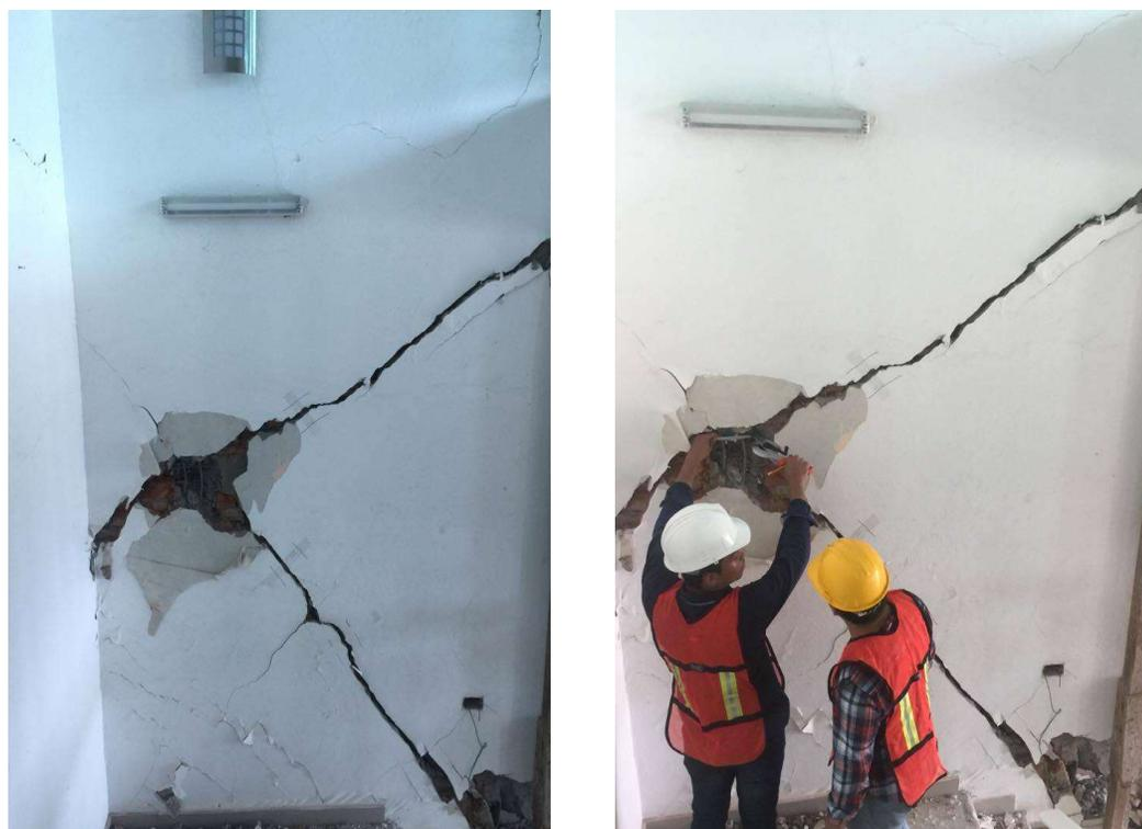
*Figura 20. Daño en Muro Planta Baja Eje 3-4-D.*
