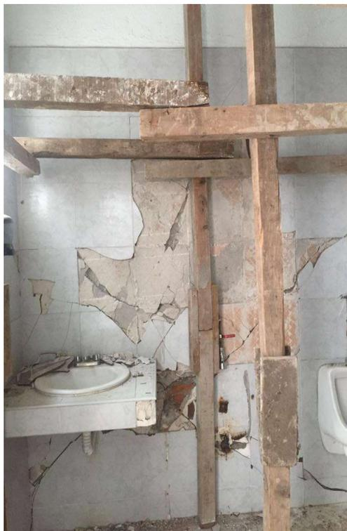
*Figura 21. Daño en Muro Planta Alta Eje D-3.*
