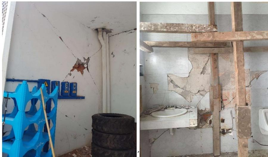
Figura 85. Falla de muro del eje D' planta baja y alta ( $V_U > V_R$ ).
