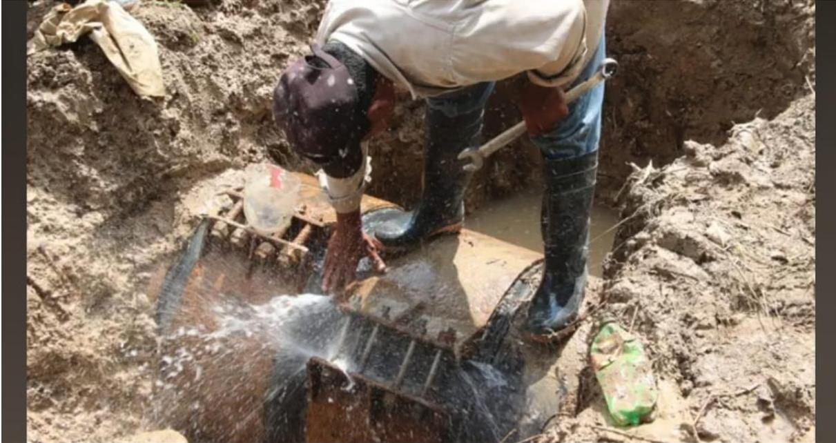
**Foto 5.** Fuga en línea de conducción de 30” de diámetro en Calzada Andrés Serra Rojas, SMAPA, Tuxtla Gutiérrez.
