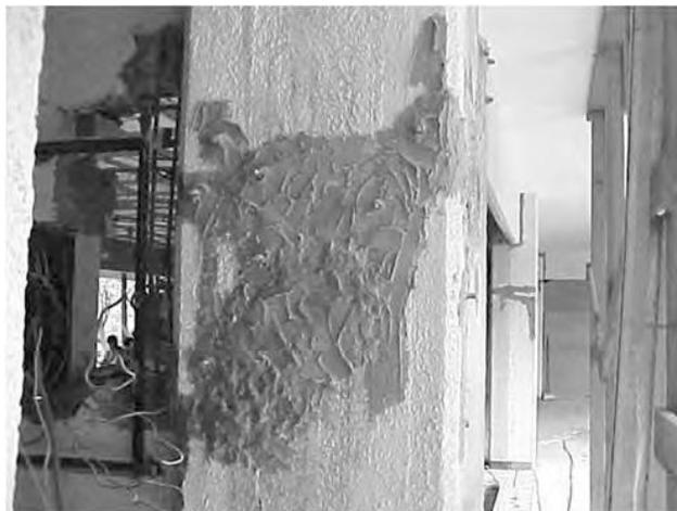
*Figura 21. Inyección de grietas en columnas<sup>18</sup>*
