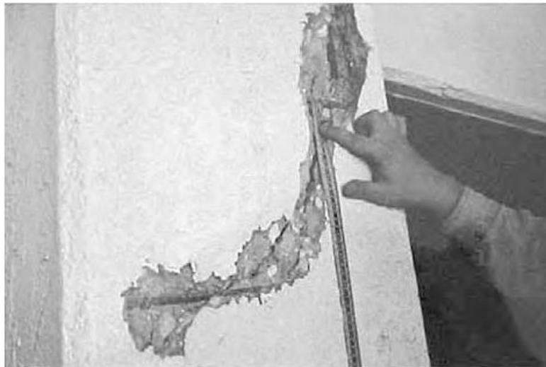
*Figura 19. Daños en columnas<sup>16</sup>*
