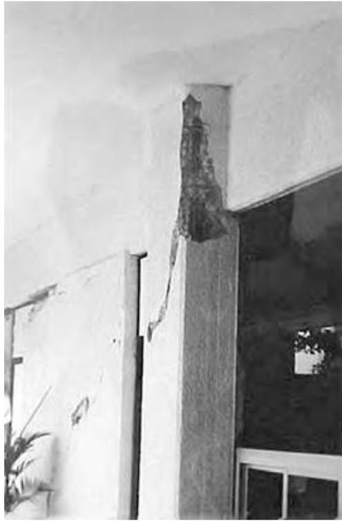
*Figura 18. Daños en columna con pretil superior<sup>15</sup>*
