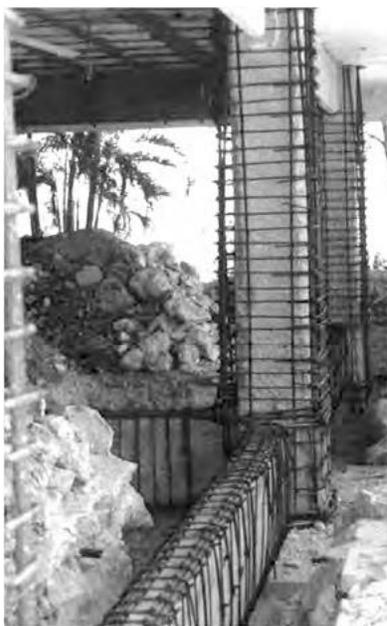
*Figura 22. Refuerzo en columnas y contratabes mediante encamisado<sup>19</sup>*
