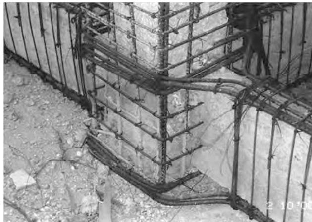
*Figura 26. Detalle del refuerzo en unión columna con contratabe<sup>21</sup>*
