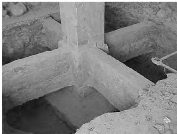
Figura 15. Detalle de cimentación original<sup>13</sup>
