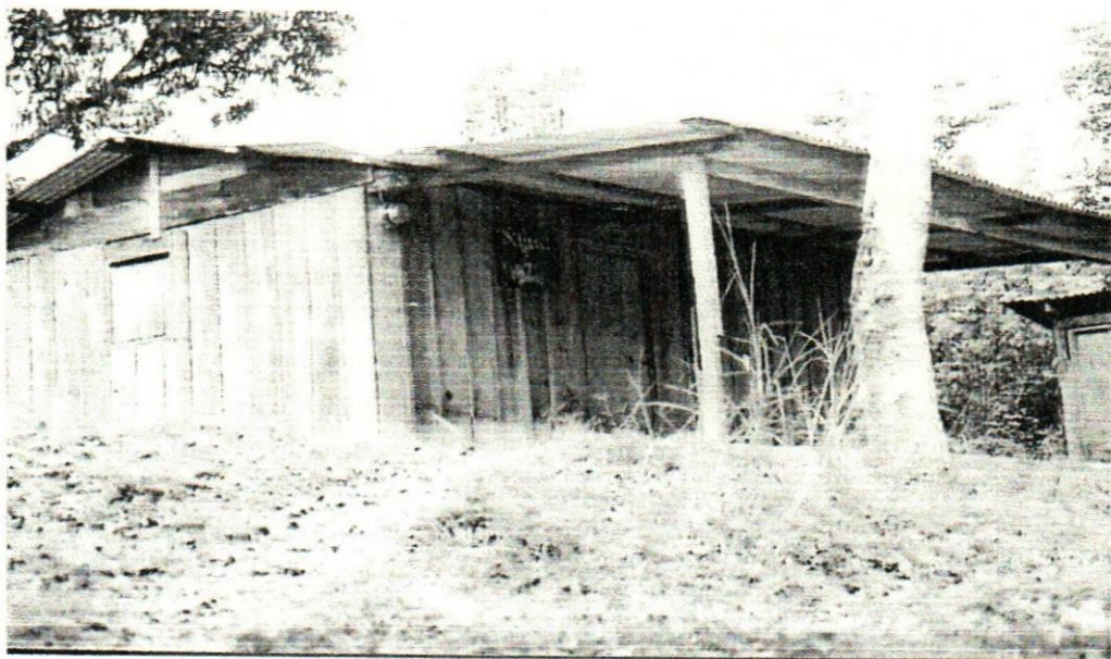
Casa de Salud en la Ranchería Filadelfia Foto: Yadira Grajales Pinto
