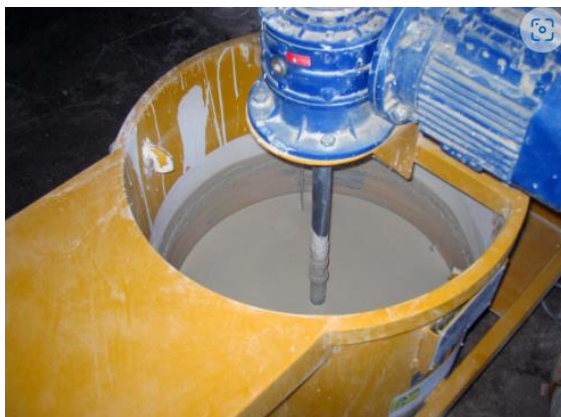
Figura 3.7 Mezclado del mortero para la inyección en mampostería (Kimia, 2014)
