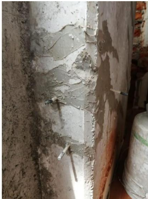
Figura 3.5 Conclusión del proceso de inyección antes del retiro de boquillas y exceso de sello (Abarca, 2022)
