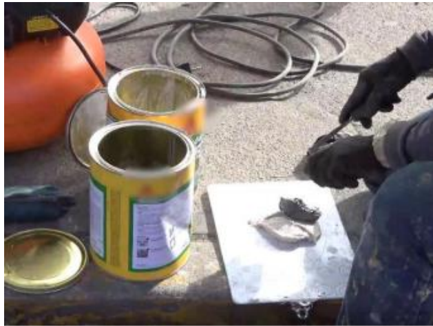
Figura 3.2 Preparación de mortero epóxico como sellador de grietas (Abarca, 2022)
