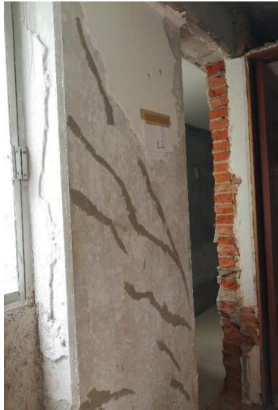
Figura 3.6 Conclusión del proceso de inyección posterior al retiro de boquillas y exceso de sello (Abarca, 2022)
