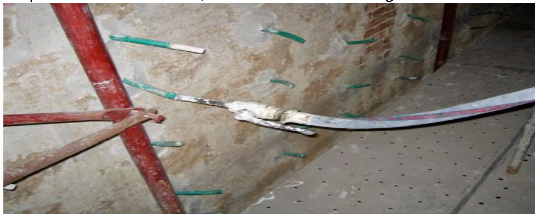
Figura 3.10 Inyección de morteros a presión (Kimia, 2014)
