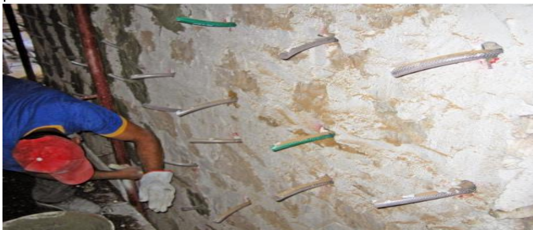
Figura 3.8 Inserción de boquillas (Kimia, 2014)
