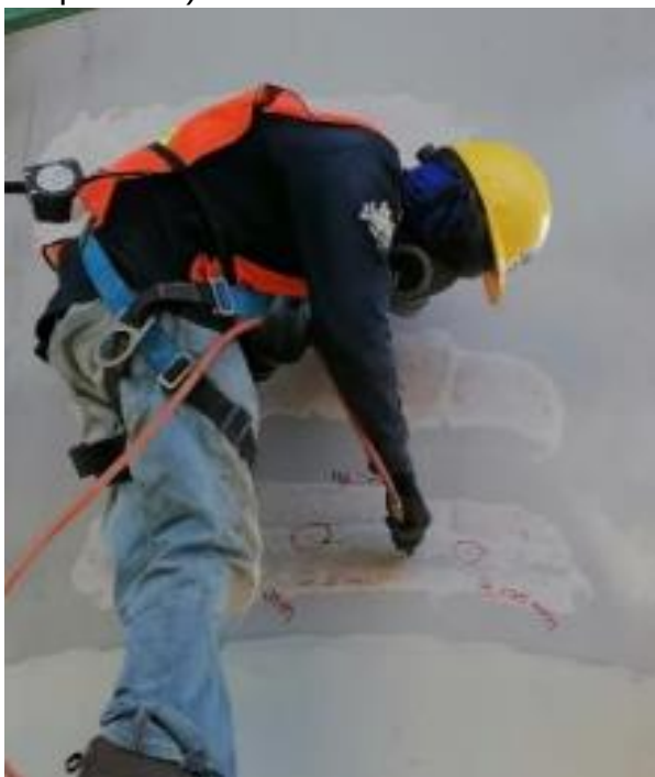
Figura 3.1 Limpieza de grietas con un compresor de aire (Abarca, 2022)
