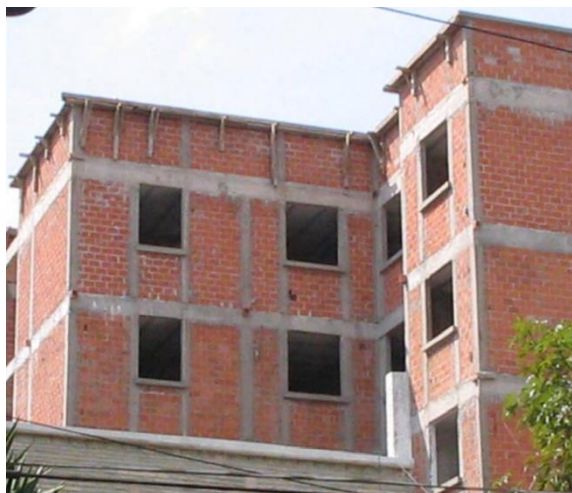
Figura 2.2 Estructura de mampostería confinada (Flores, 2007).
