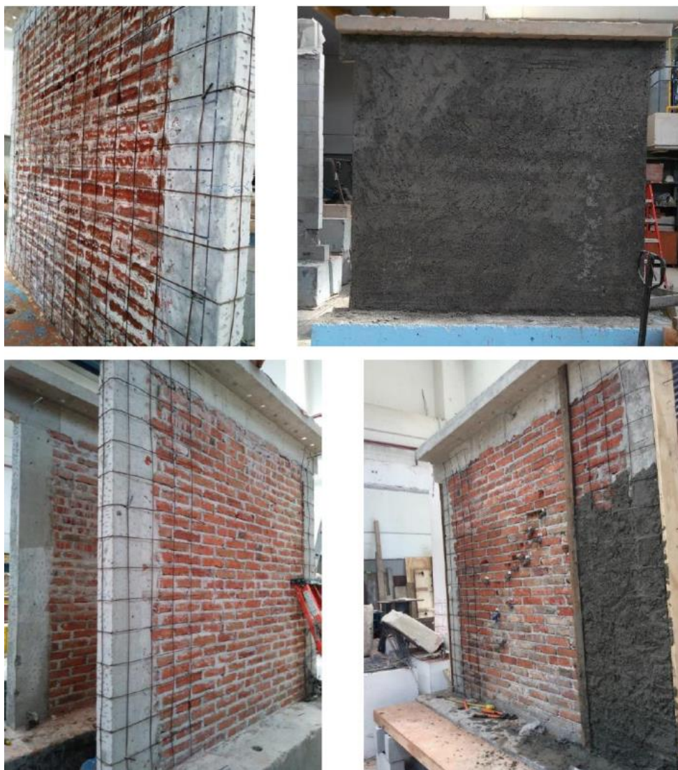
Figura 3.16 Proceso de refuerzo con malla y mortero (CENAPRED, 2022)
