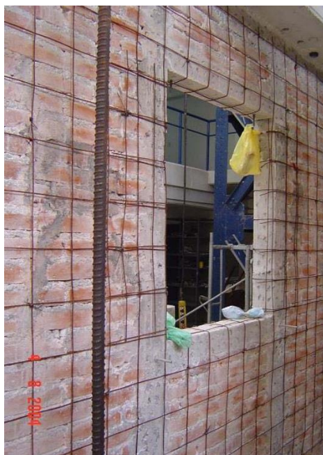
Figura 6.1 Colocación de malla de refuerzo en muro de mampostería con aberturas (CENAPRED, 2013).
