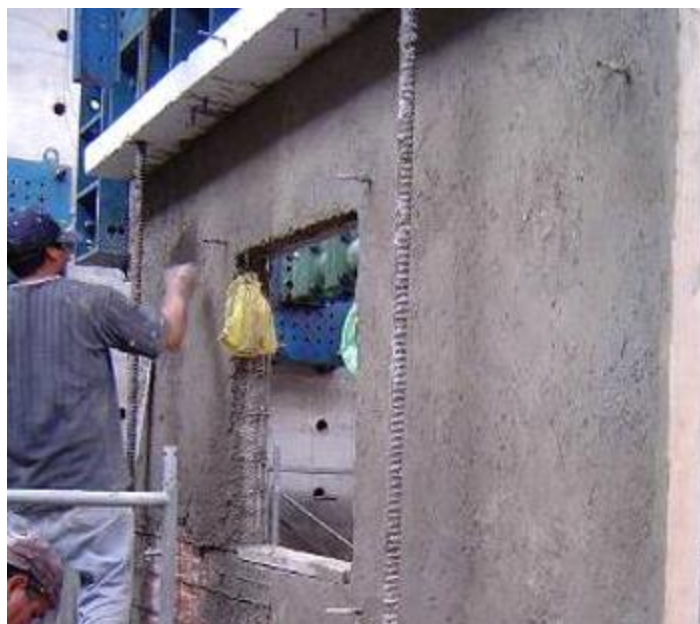
Figura 6.2 Colocación de la capa de mortero en muros de mampostería con refuerzo de malla (CENAPRED, 2013).
