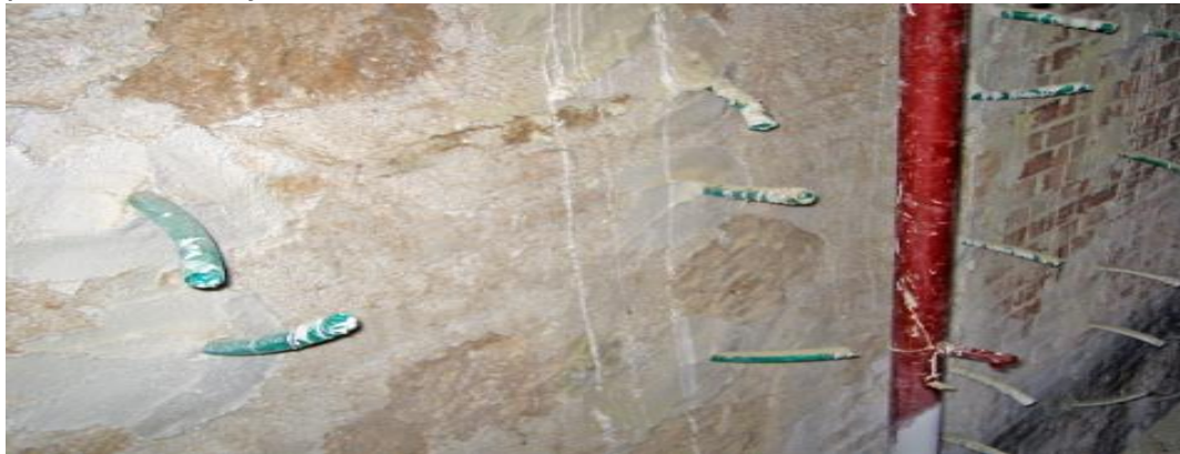
Figura 3.9 Sellado de boquillas (Kimia, 2014)
