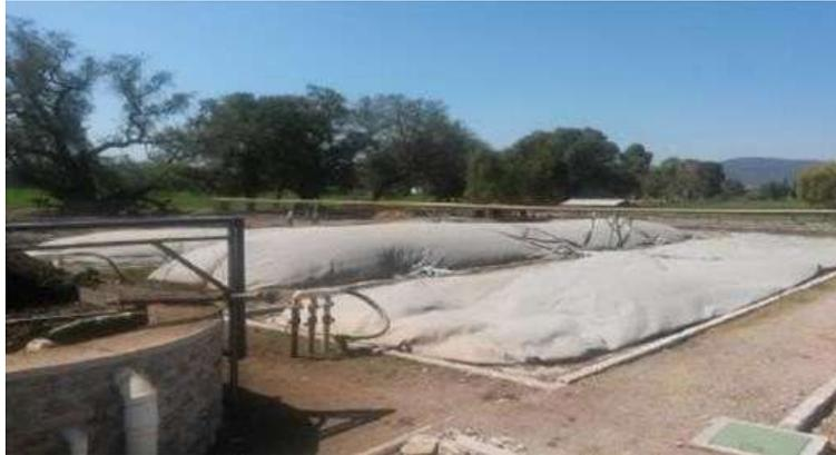
**Figura 5.** Reactor anaerobio tipo laguna
