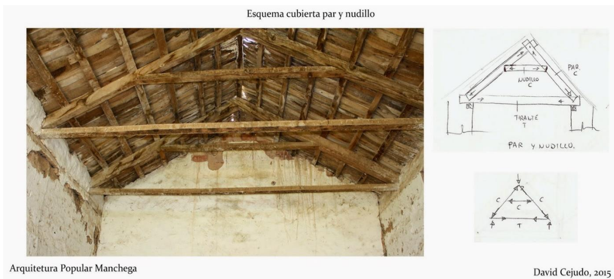
Figura 18. Imagen de cubierta de par y nudillo sobre muros de adobe. Tomada de http://www.arquitecturapopularmanchega.es/2015/02/cap99-sistemas-constructivos-ii.html , el primero de julio del 2022.
