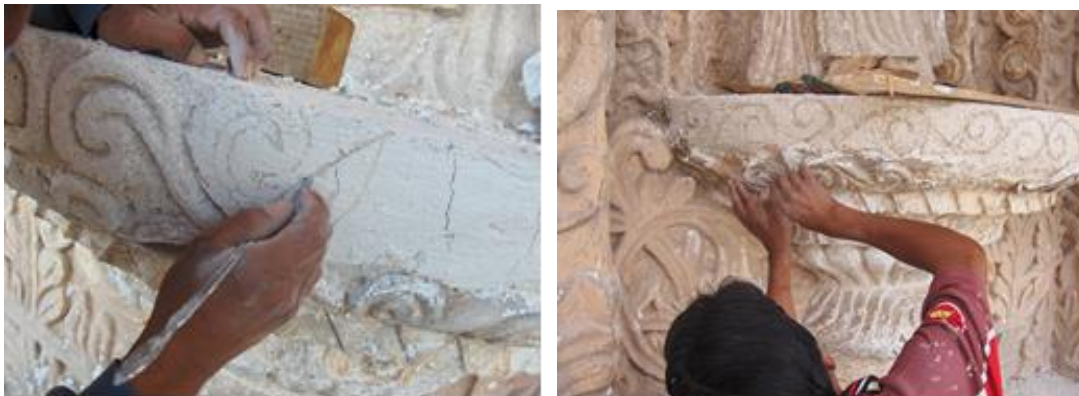
Figs. 77 y 78. Corte y modelado de los relieves. Fotos: María Elena Fernández
