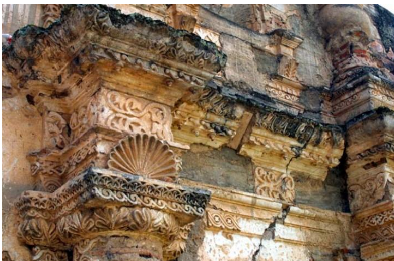
Figura 23. Detalle de la decoración de la fachada de la Candelaria en Antigua dónde se aprecia su enorme semejanza con al de Santo Domingo en Ciudad Real 706
