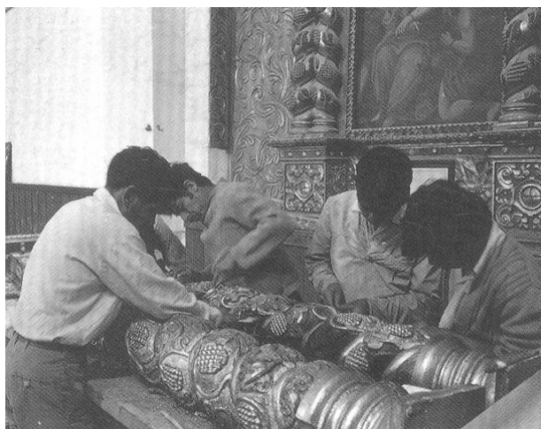
Figura 46. Trabajos de conservación de los retablos de la capilla del Calvario 788 .
