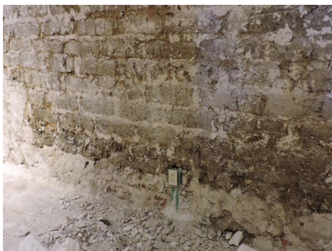
Figura 22. A la izquierda, uno de los muros de la planta baja del convento realizados con adobes. Los cimientos fueron realizados con piedra. A la derecha muro con ventanal con refuerzo en el arco de ladrillos. La imagen fue tomada durante los trabajos de reposición de los aplanados de cal y arena dañados por el sismo de 2017. Fotos: Haydeé Orea
