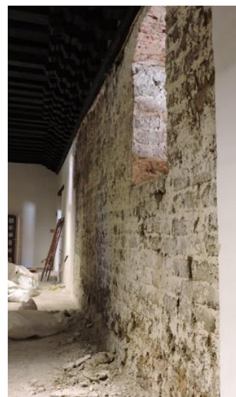
Figura 22. A la izquierda, uno de los muros de la planta baja del convento realizados con adobes. Los cimientos fueron realizados con piedra. A la derecha muro con ventanal con refuerzo en el arco de ladrillos. La imagen fue tomada durante los trabajos de reposición de los aplanados de cal y arena dañados por el sismo de 2017. Fotos: Haydeé Orea
