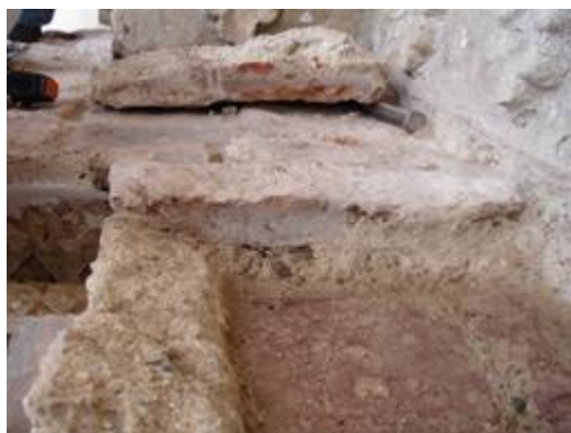
Fig. 63. Detalle de la argamasa que forma la cornisa de pecho de paloma y del ladrillo biselado. Foto: María Elena Fernández
