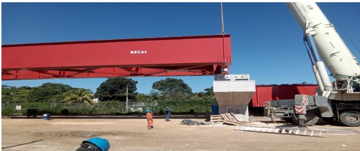
La Empresa encargada de fabricar las estructuras mecánicas (Dovelas) para lo que sería la construcción del Viaducto (Escárcega/Campeche):
