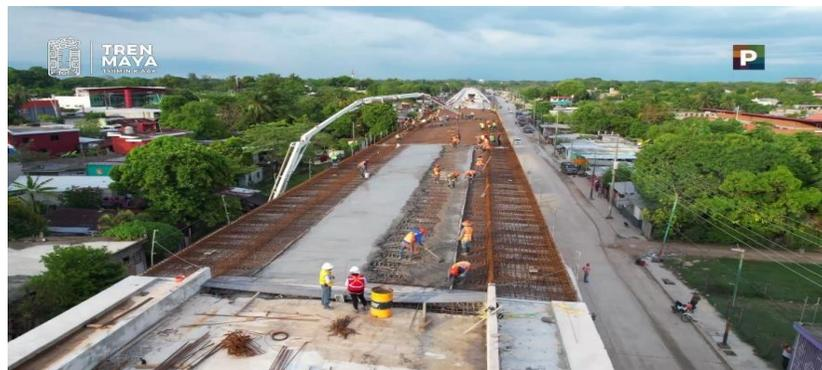
Figura 2. – Construcción del armado de plataforma con acero de diferentes dimensiones de acuerdo al plano Ejecutivo constructivo, en el municipio de Escárcega.
