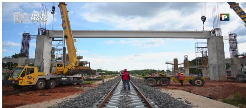
Figura 3. – Colocación de Estructura de concreto armado en forma de Marco soportante para la plataforma de carriles. Proyecto Ejecutivo-Constructivo, en el municipio de Escárcega.
