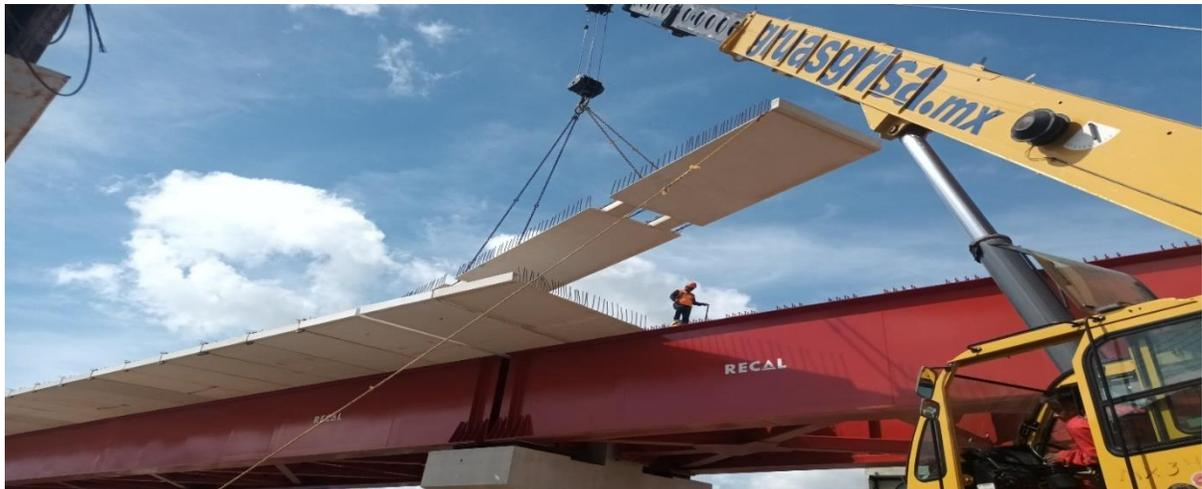
Figura 60.- Colocación, izaje y montaje de la prelasas según lo estipulado en el plano del proyecto.
