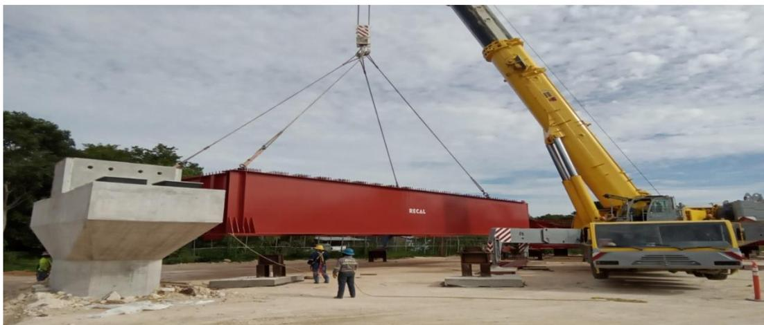
Figura 54.- Izaje de Dovela con Grúa y personal capacitado para su colocación.
