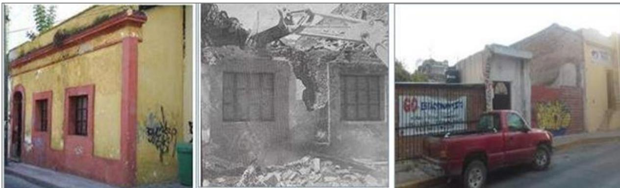
Nota. Primera y segunda imagen, como fue la vivienda. La falta de mantenimiento provocó el deterioro y la saturación de humedad generó el derrumbe en su estructura en una parte de la edificación (foto propia Pérez, 2008). La tercera imagen, nos muestra el estado actual en deterioro del predio sin vivienda (Foto Pérez, 01 abril de 2017).
