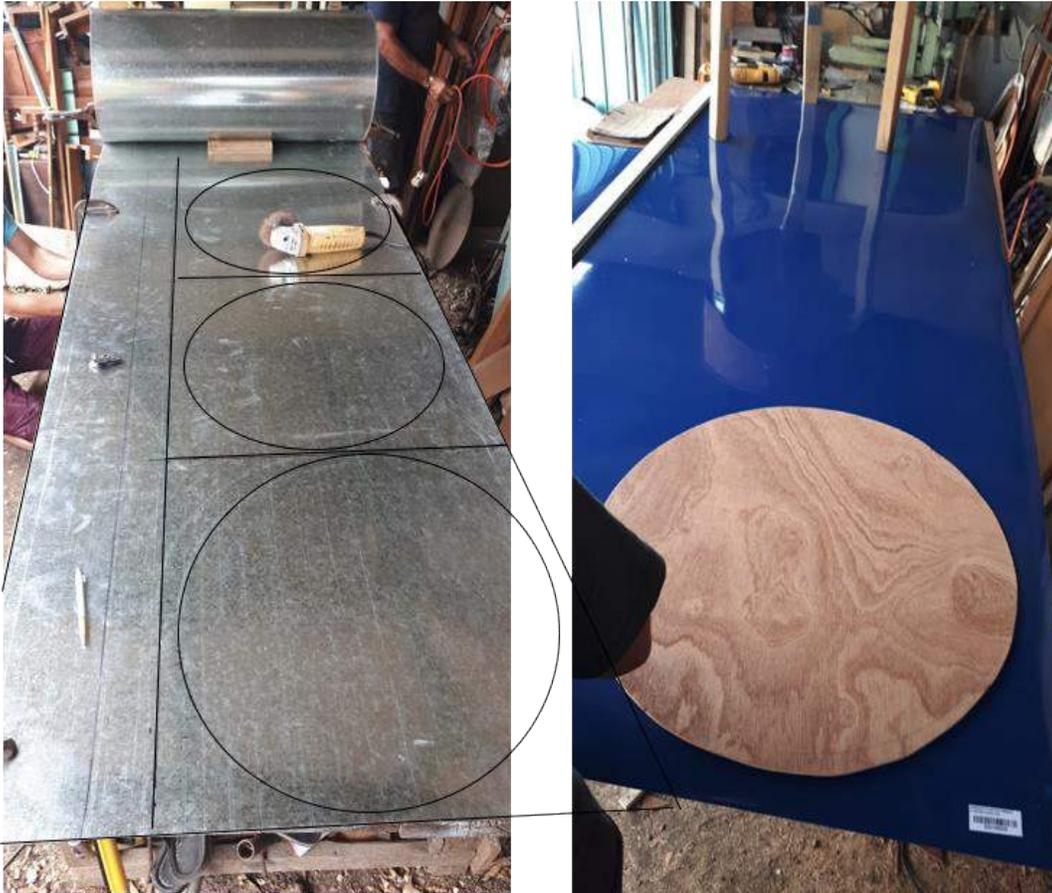
*Nota:* Trazo de los elementos del fogón ecológico en los materiales para su construcción.
