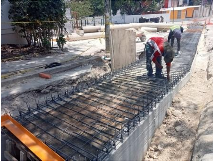
Imagen 2. Canal de concreto armado.
