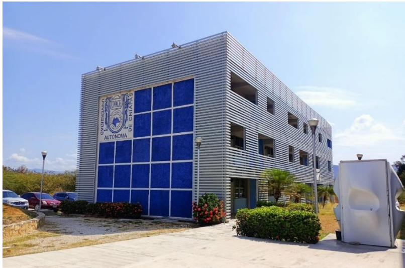
Edificio Centro de Educación a Distancia. Fuente: Gómez, (marzo 2022)
