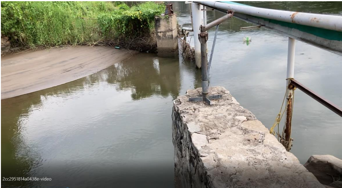
Sedimentos en la obra de toma actual. (Fuente propia 2023).
