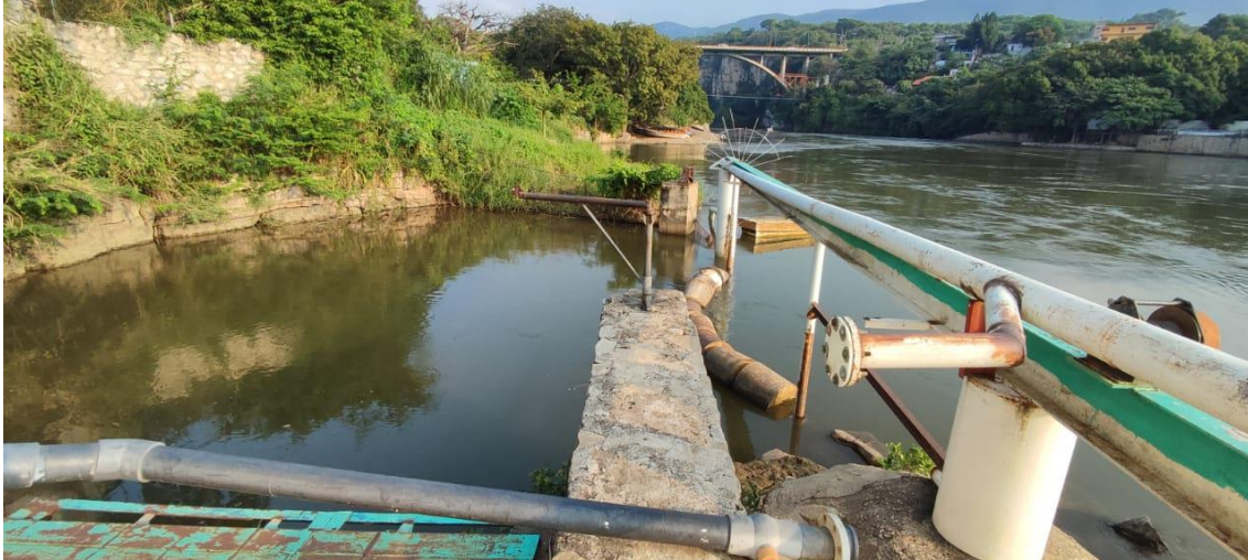
Obra de toma actual de Ciudad del Agua. (Fuente propia 2023).
