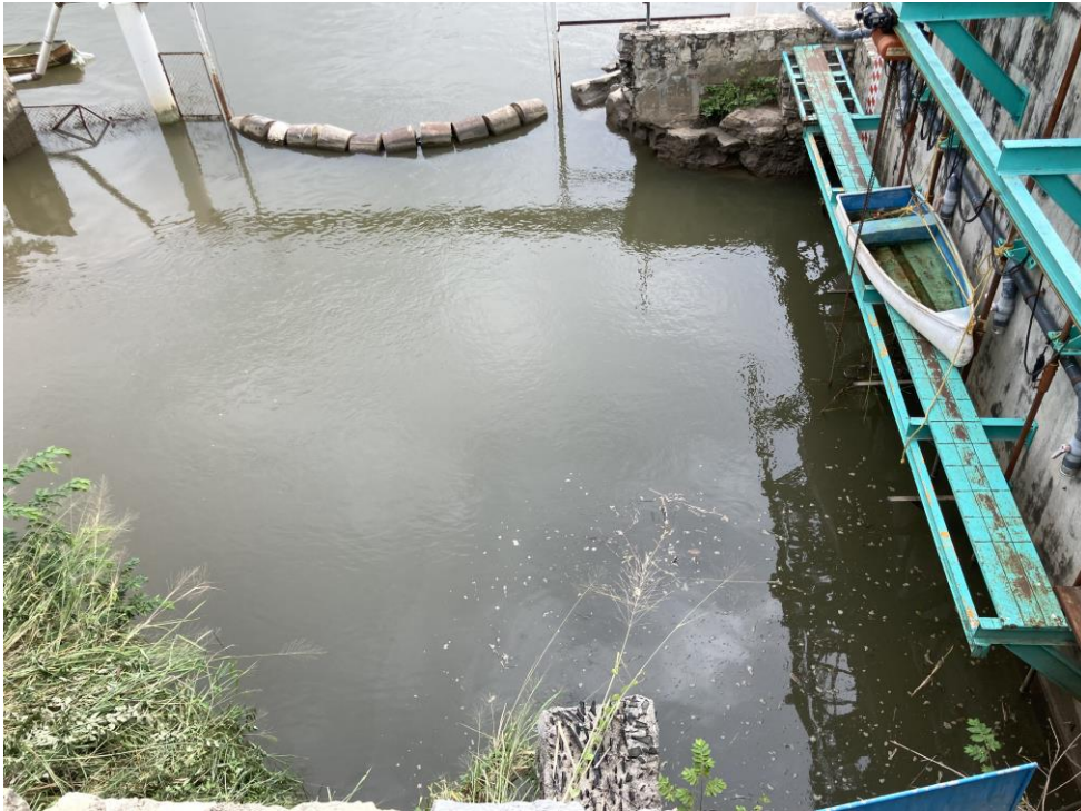
Entrada actual de la obra de toma. (Fuente propia 2023).
