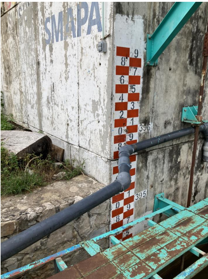
Nivel de cota de entrada en la obra de toma. (Fuente propia 2023).
