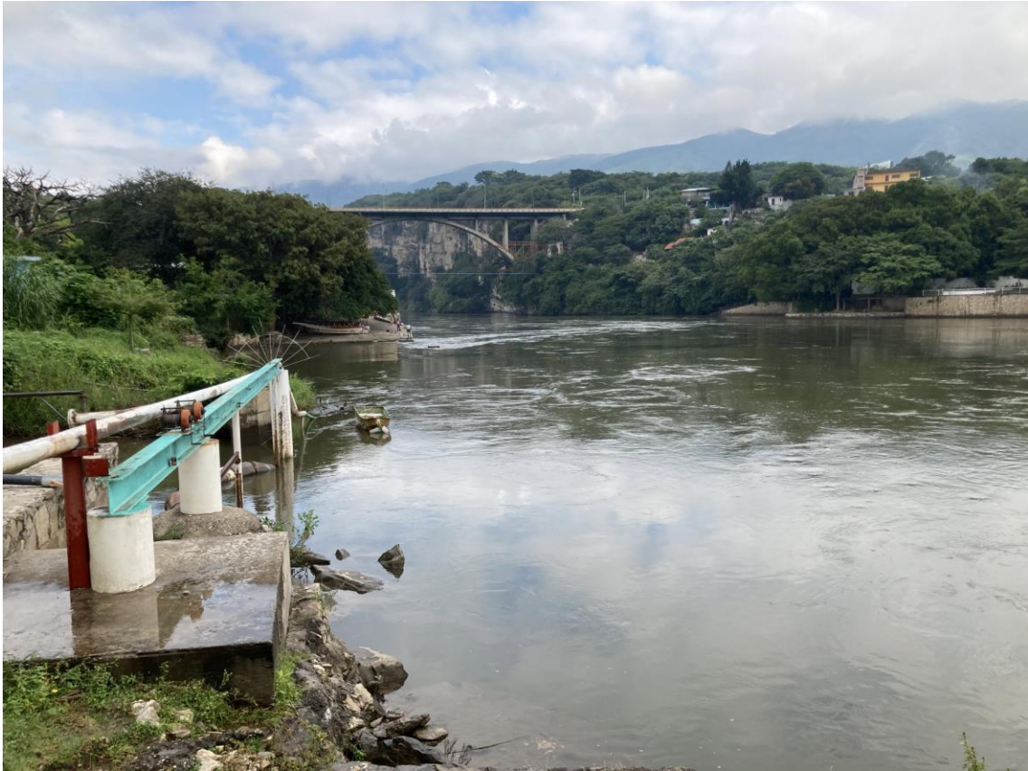
Se observa la entrada de la obra de toma y el Puesto Belisario Domínguez, en el puente Colgante se encuentra instalada la estación hidrométrica Cañón del Sumidero. (Fuente propia 2023).
