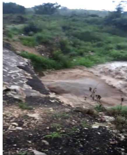
Figura No. 2. Obra de drenaje trabajando al 100% de su capacidad hidráulica.
