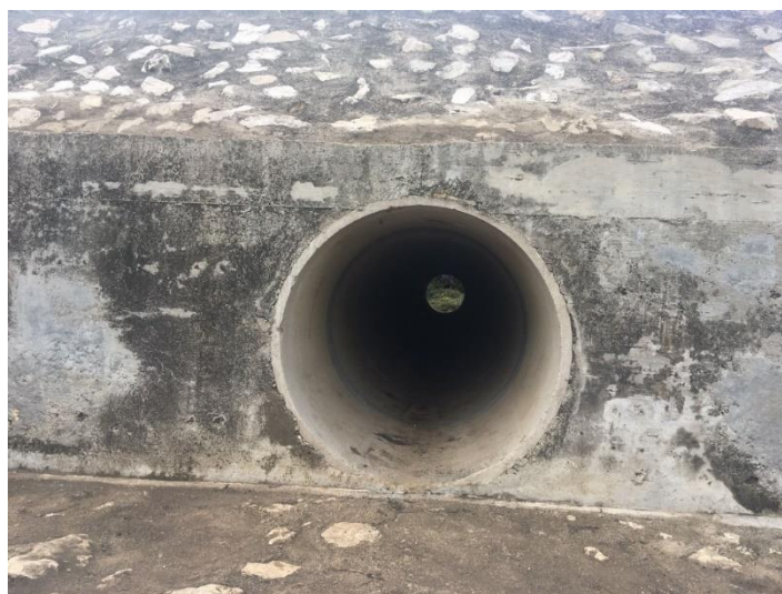
Figura No. 12. Obra de drenaje en el km 91+989 lado izquierdo.
