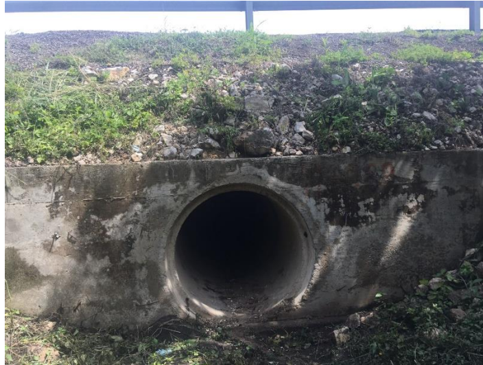
Figura No. 13. Obra de drenaje en el km 91+989 lado derecho.
